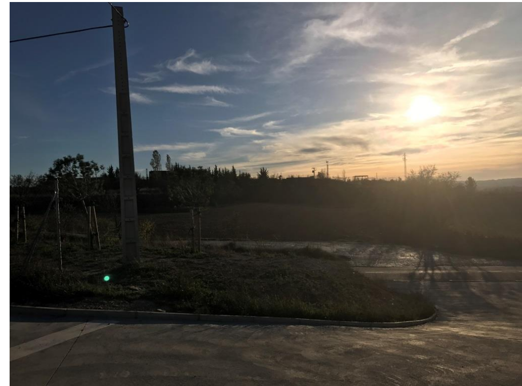
Il·lustració 2: Pas de la carretera línia aèrea
