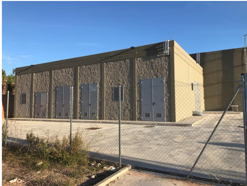
Il·lustració 1: Exterior del dipòsit i futura ubicació caseta comptadors
