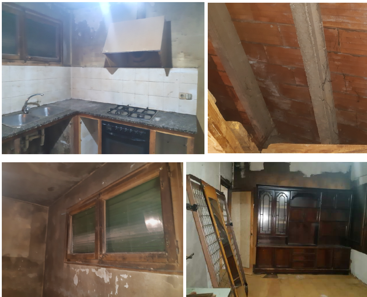
Estat actual de l'interior de l'habitatge
