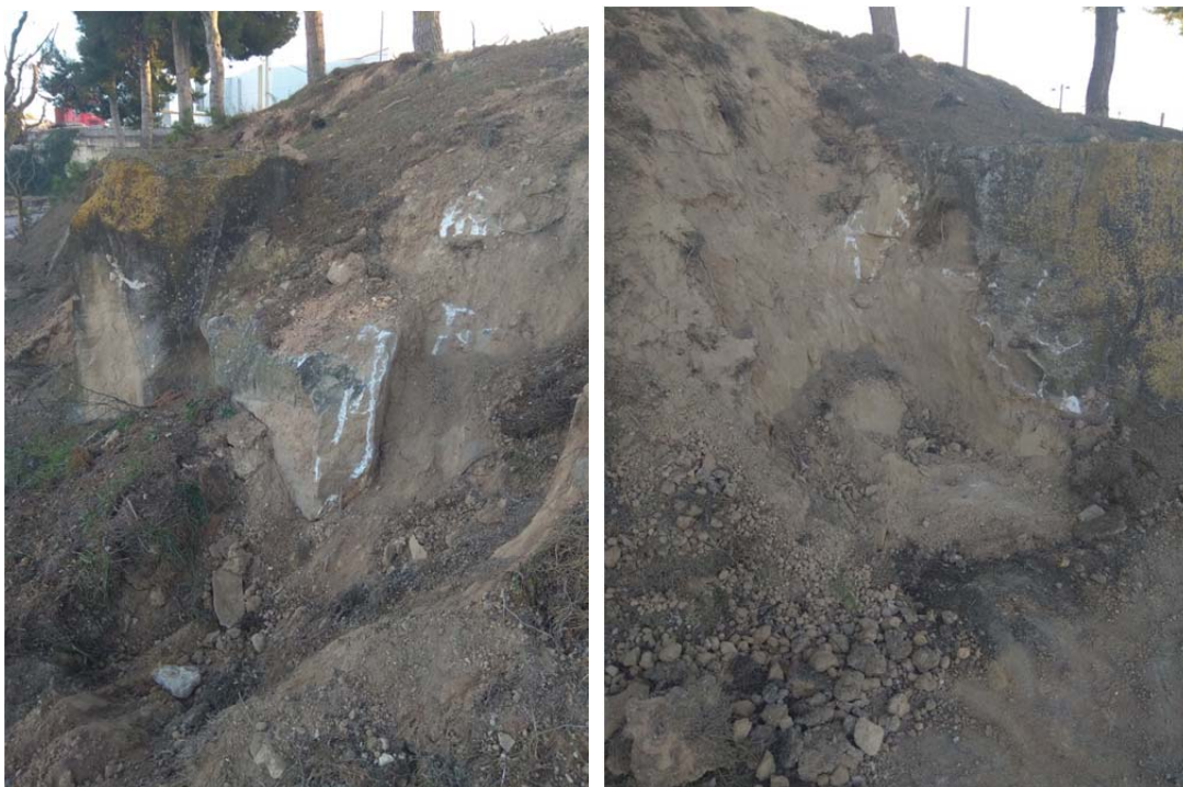
Imatges cales excavades en zona de talús, en indret del mur
