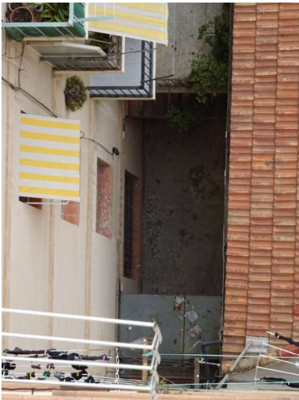
PATI ACCÉS MAGATZEM (FUTUR OFFICE PERSONAL)
