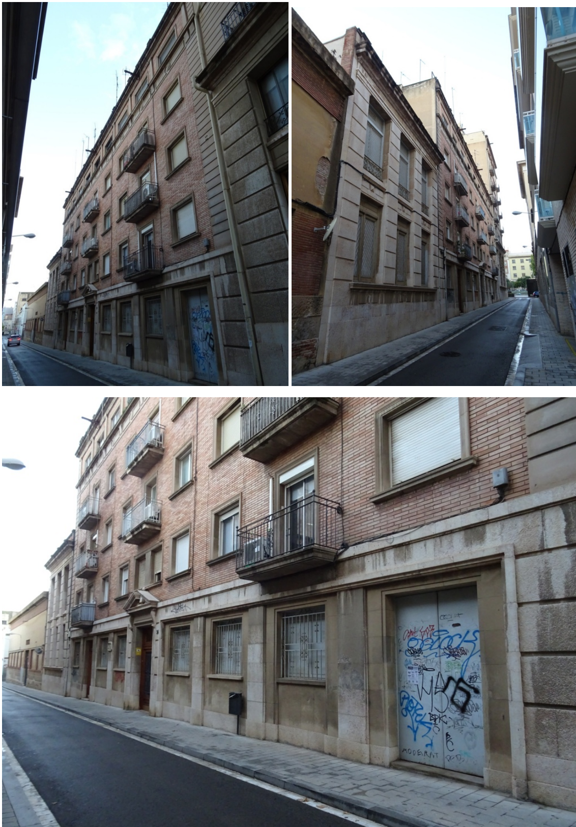
FAÇANES CARRERS DE JOSEP ANSELM CLAVÉ. ENTRADA MAGATZEM (dreta)
