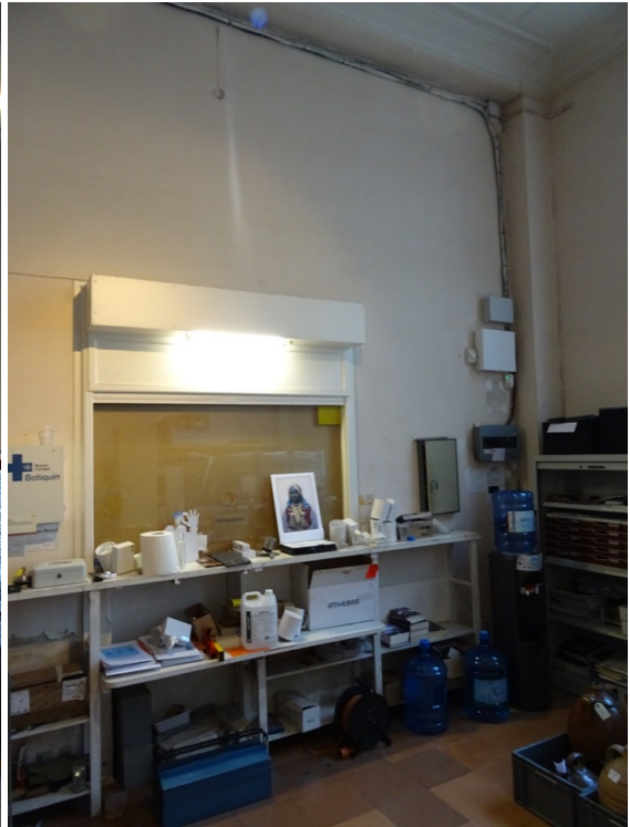
ANTIGA FINESTRA RECEPCIÓ
