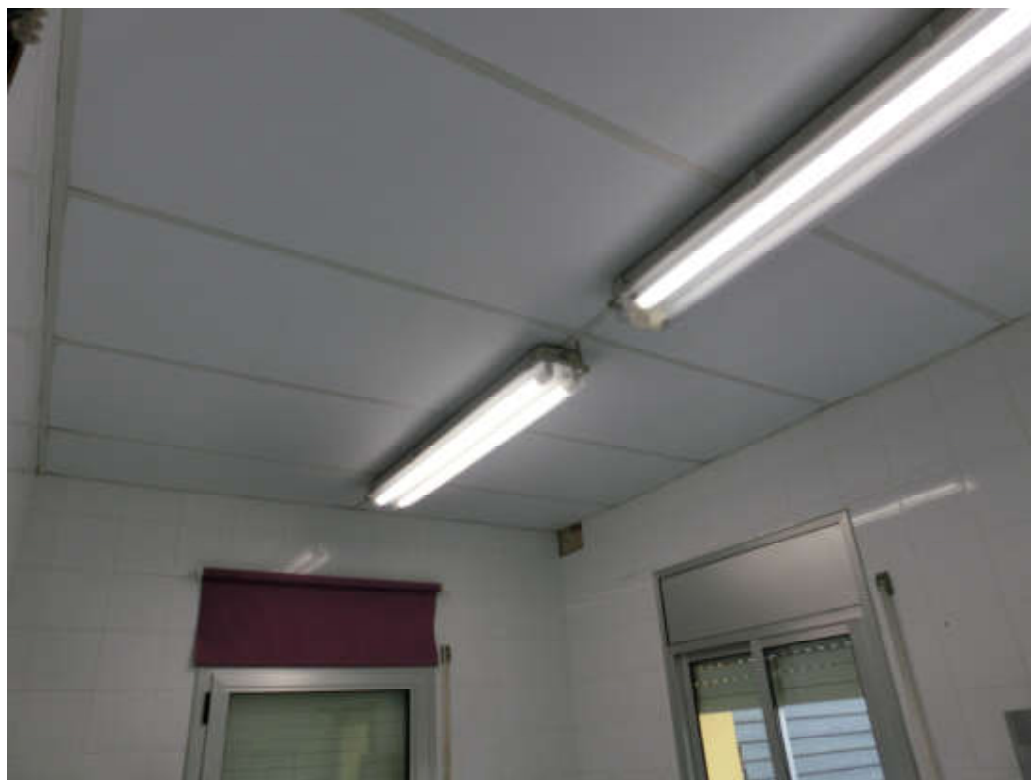
Fals sostre de la sala obrador.
