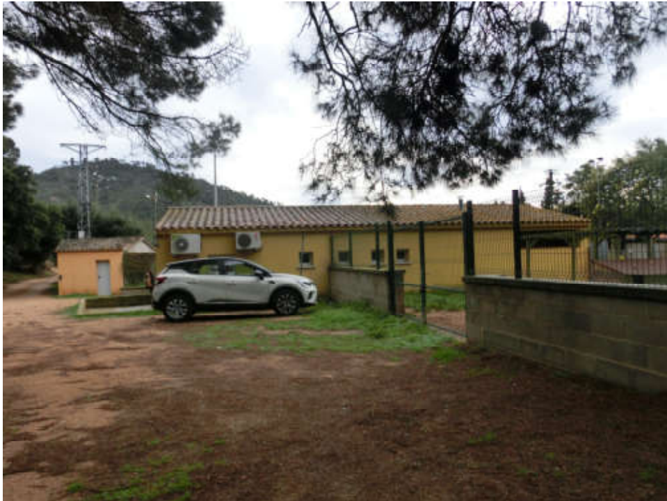
Vista general de l'edifici principal i entrada a la zona de la nova nau.
