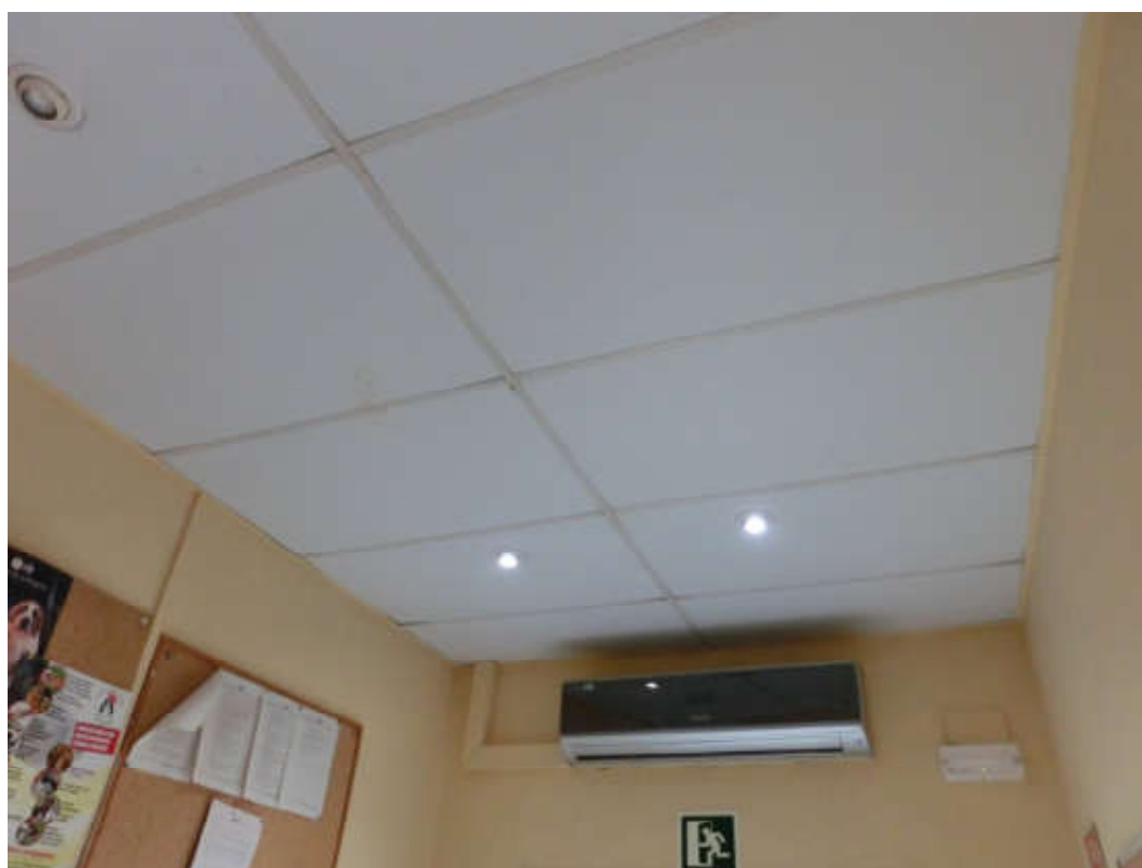
Vista del fals sostre de l'entrada.
