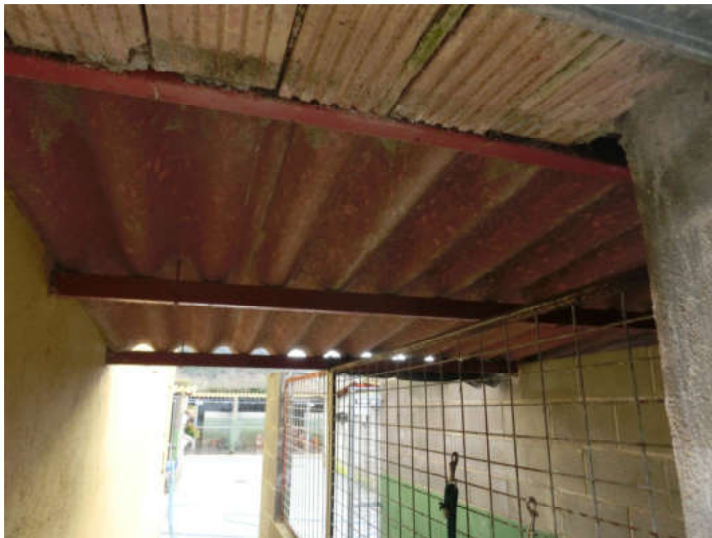
Imatge de les plaques de fibrociment de les gàbies a enretirar.
