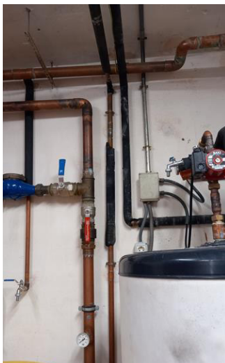
Figura 4: Canonades de la instal·lació de calefacció existents.
