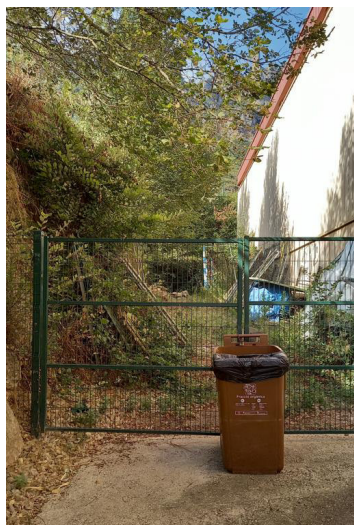
Figura 6: Ubicació de la sala de caldera de biomassa.
