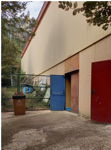
Figura 21: Paret on cal perforar per l'entrada dels tubs.
