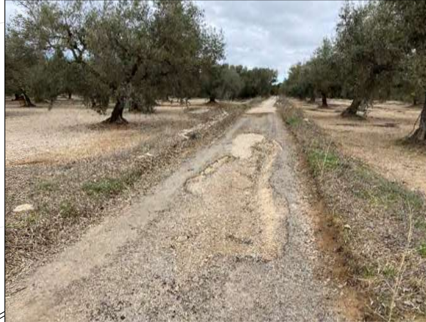
CAMÍ PLANES NOVES AMB EL PAVIMENT ARRENCAT O EROSIONAT PER L'ESCORRENTIU AL LLARG DE TOT EL SEU TRAÇAT
