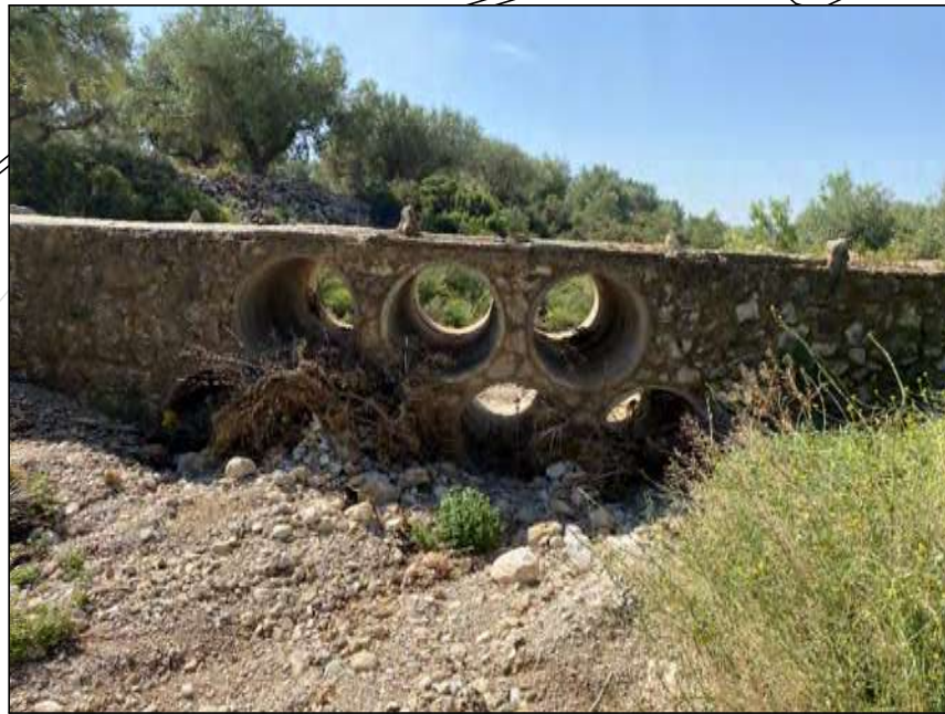
CAMÍ DE LES RIBETES AMB EL PAVIMENT EROSIONAT I L'OBRA DE PAS DEL BARRANC COLMATADA AMB GRAVES I RAMES ARRASTRADES PER L'ESCORRENTIU
