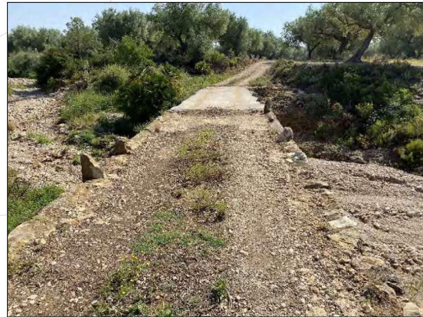
CAMÍ DE LES RIBETES AMB EL PAVIMENT EROSIONAT I L'OBRA DE PAS DEL BARRANC COLMATADA AMB GRAVES I RAMES ARRASTRADES PER L'ESCORRENTIU
