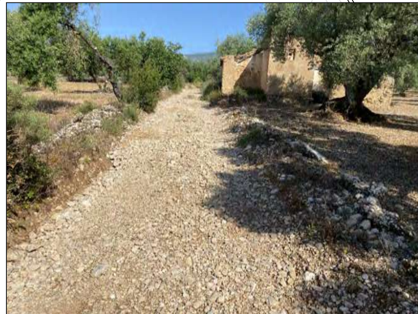
CAMÍ TRANSVERSAL PLANES NOVES 1 EROSIONAT ON ES VEU LA ROCA INICIAL DEL CAMÍ. PER A PERMETRE EL TRANSIT ES VA EXTENDRE UNA CAPA DE GRAVA GROSSA DE FORMA PROVISIONAL. AQUESTA NO ÉS UNA SOLUCIÓ DURADORA PEL QUE S'HA D'ARRANJAR EL CAMÍ DE FORMA PERMANENT
