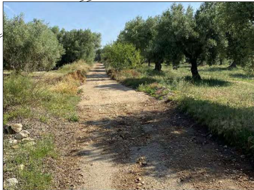
CAMÍ PLANES NOVES AMB EL PAVIMENT ARRENCAT O EROSIONAT PER L'ESCORRENTIU AL LLARG DE TOT EL SEU TRAÇAT
