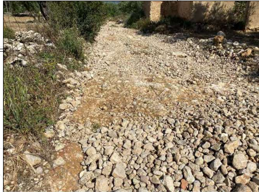
CAMÍ TRANSVERSAL PLANES NOVES AMB EL PAVIMENT ARRENCAT O EROSIONAT PER L'ESCORRENTIU
