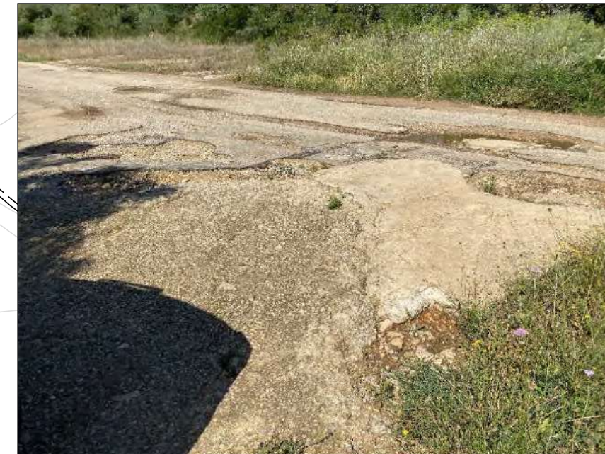
CAMÍ TRANSVERSAL PLANES NOVES 1 EROSIONAT ON ES VEU LA ROCA INICIAL DEL CAMÍ. PER A PERMETRE EL TRANSIT ES VA EXTENDRE UNA CAPA DE GRAVA GROSSA DE FORMA PROVISIONAL. AQUESTA NO ÉS UNA SOLUCIÓ DURADORA PEL QUE S'HA D'ARRANJAR EL CAMÍ DE FORMA PERMANENT
