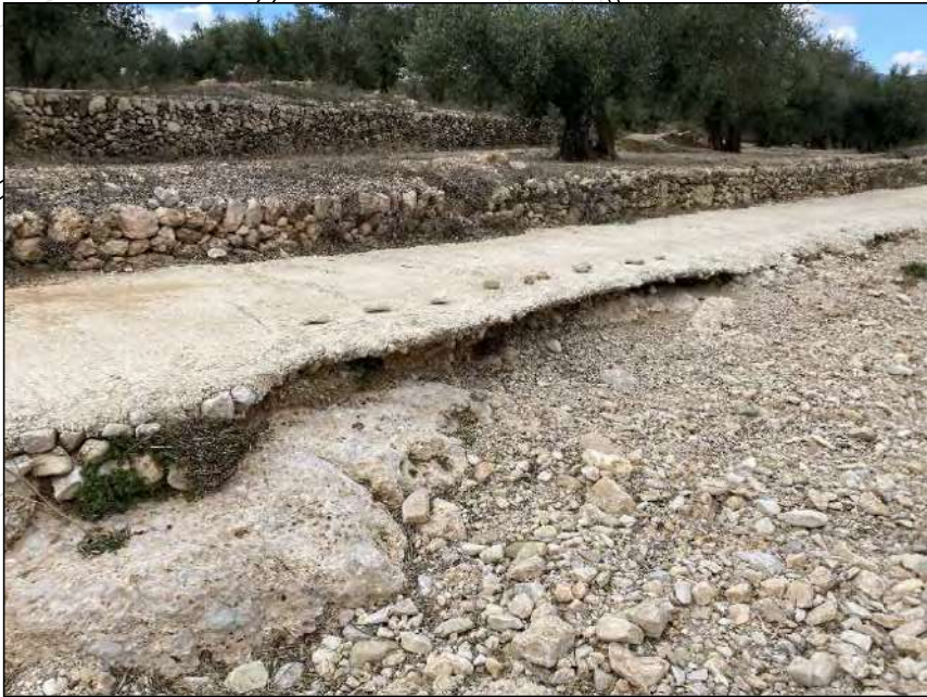
CAMÍ TRANSVERSAL PLANES NOVES AMB EL PAVIMENT ARRENCAT O EROSIONAT PER L'ESCORRENTIU
