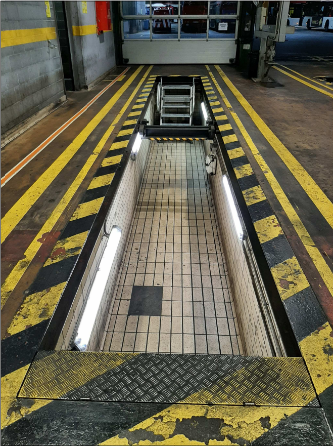
FOTOGRAFIA : ESTADO ACTUAL FOSOS
