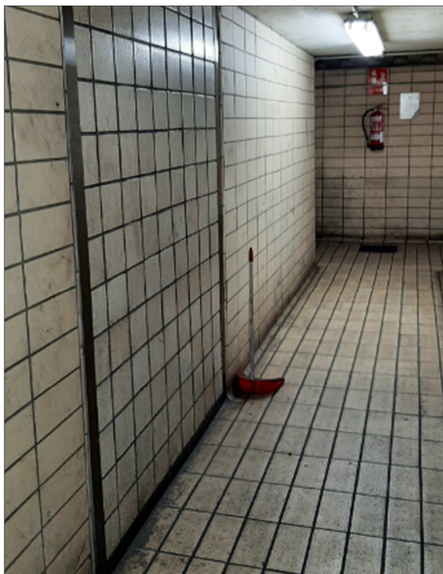
Fotografia 6. Espacio de delimitación de pasarelas de circulación interior y acceso a foso
