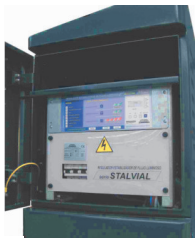
Módulo regulador de flujo hasta 45 KVA
