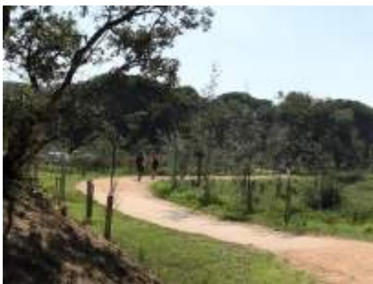
Exemple de solució passallís de sauló sòlid aplicada al camí de Castell de EMF.
