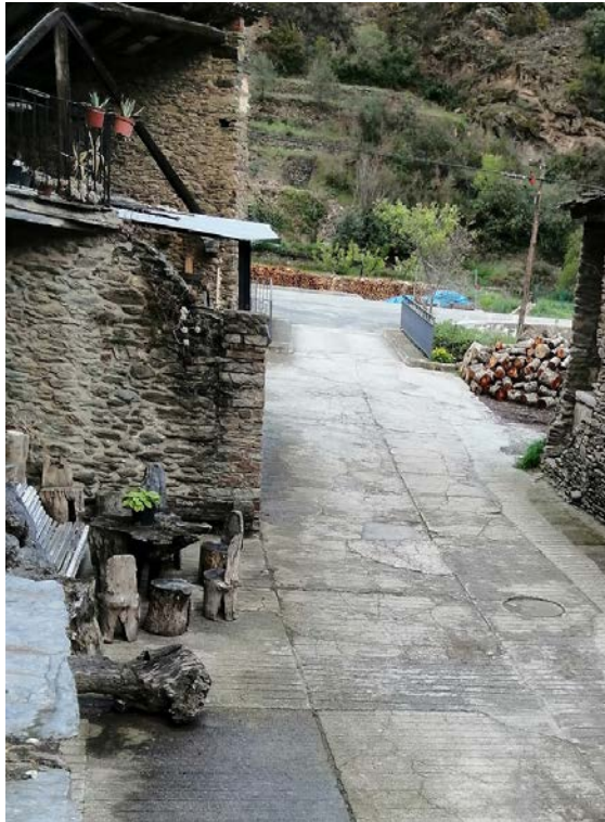
8. Pavimentar pont accés Zona 2
