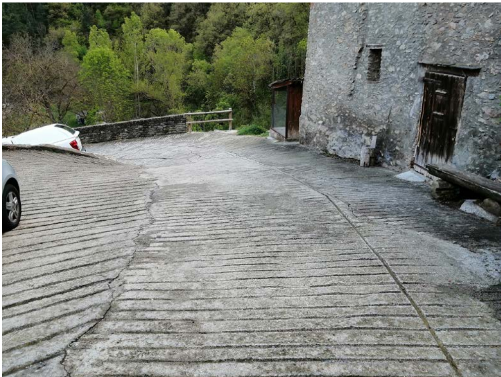
4. Allargar barana de pedra uns 4m
