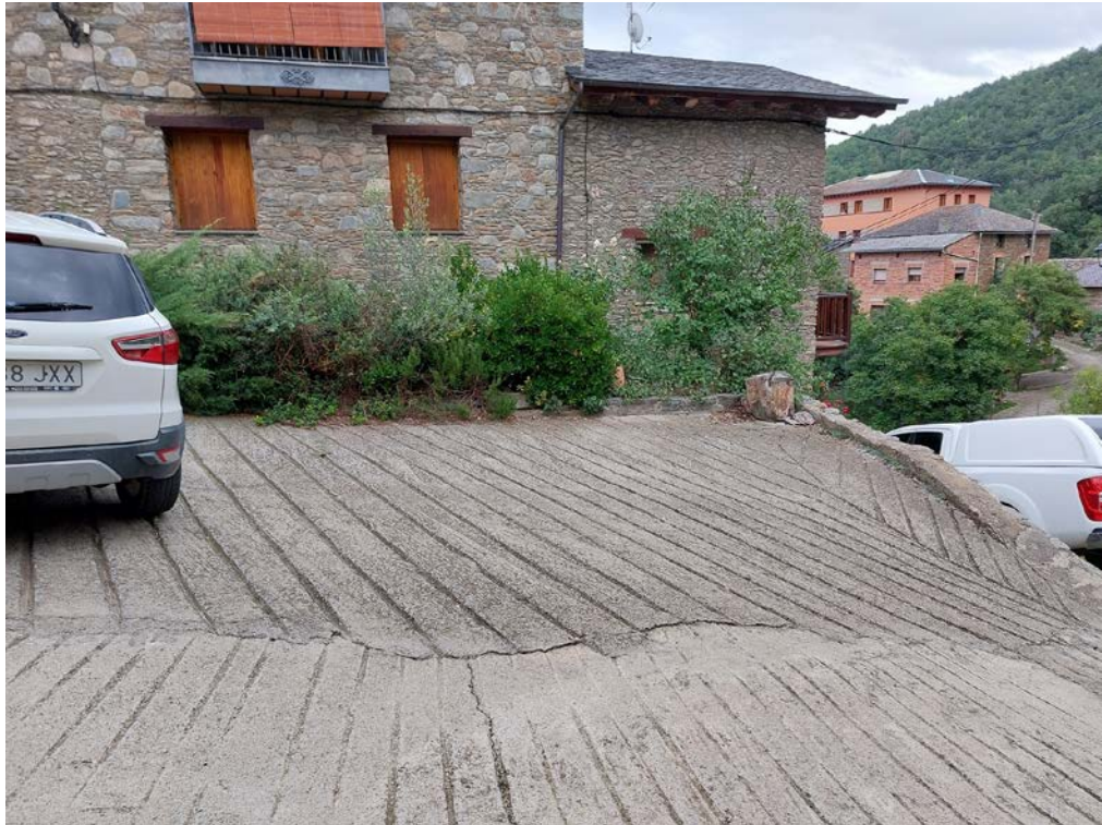
3. Col·locar barana metàl·lica en zones que superen els 55cm de desnivell
