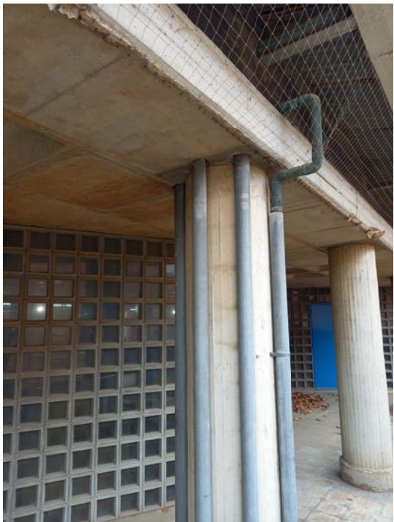
ESCOMESSES I DERIVACIONS DE CALEFACCIÓ
