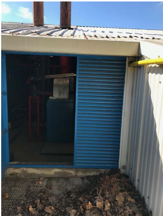
FAÇANA NORD-EST (sala calderes)
