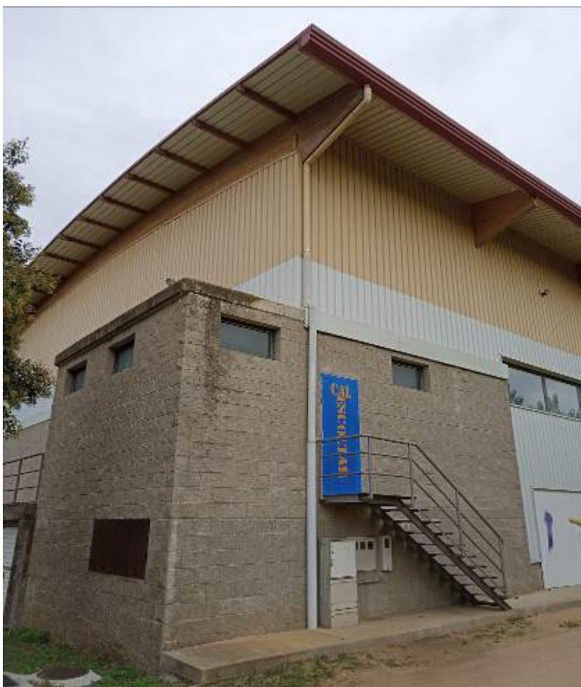
Ubicació TFM-10 i quadre distribució, a l'esquerra dels existents I baixant des de coberta, seguint el recorregut de la canal
