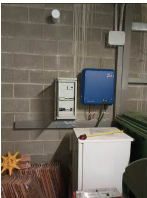
Ubicació dins magatzem brigada. Inversor existent d'injecció a xarxa i quadre general del pavelló. Els nous equips s'instal·laran al costat dret del pilar metàl·lic.
