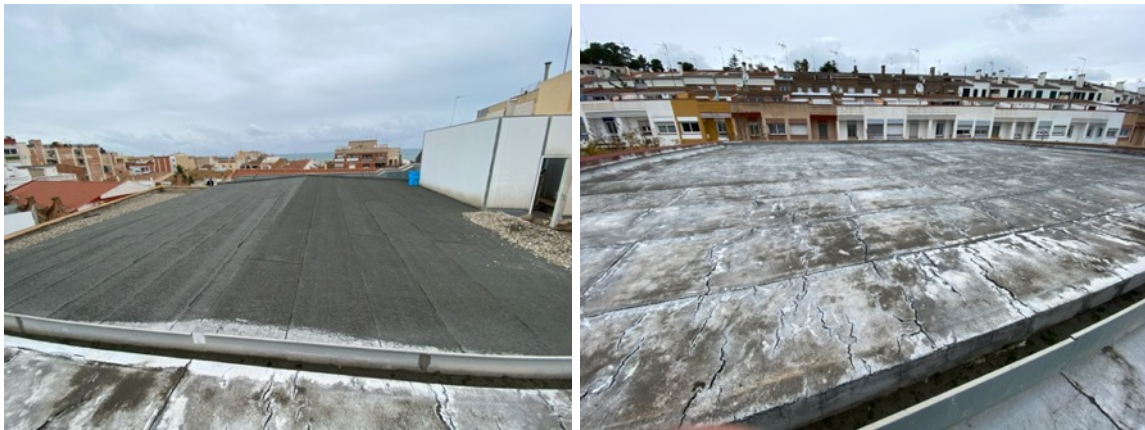
Imatge 2.1. Fotografia de les cobertes del teatre a on es substituirà la impermeabilització
