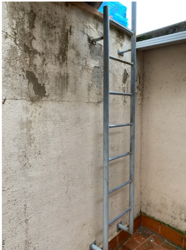
Imatge 8: Accés a les cobertes planes de l'edifici Teatre
