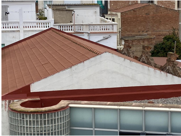
Coberta inclinada sobre estructura original 1920.
