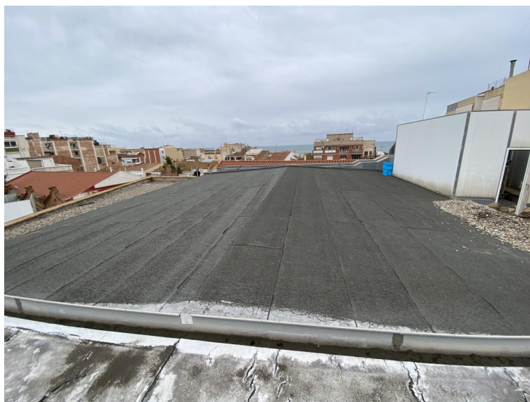
Coberta deck de la sala del teatre.
