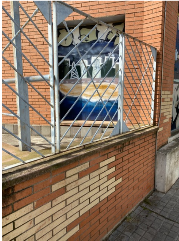
Imatge 10: Ubicació nova Escomesa – Armari CGP+TMF10
