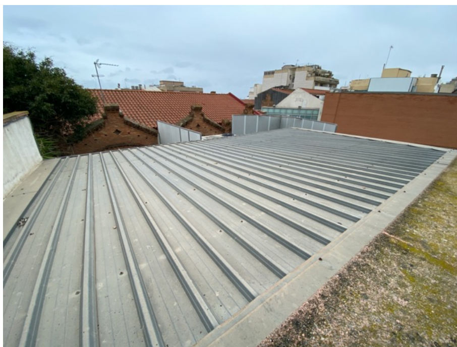
Imatge 4: Coberta edifici Annex
