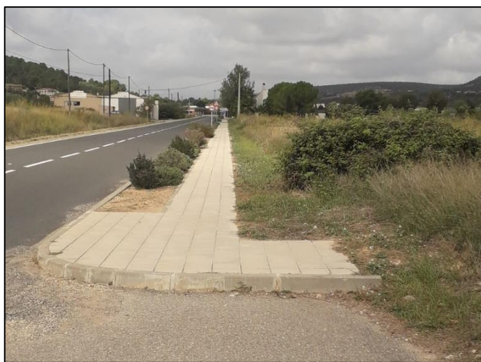
Figura 6. Tram de vorera existent
