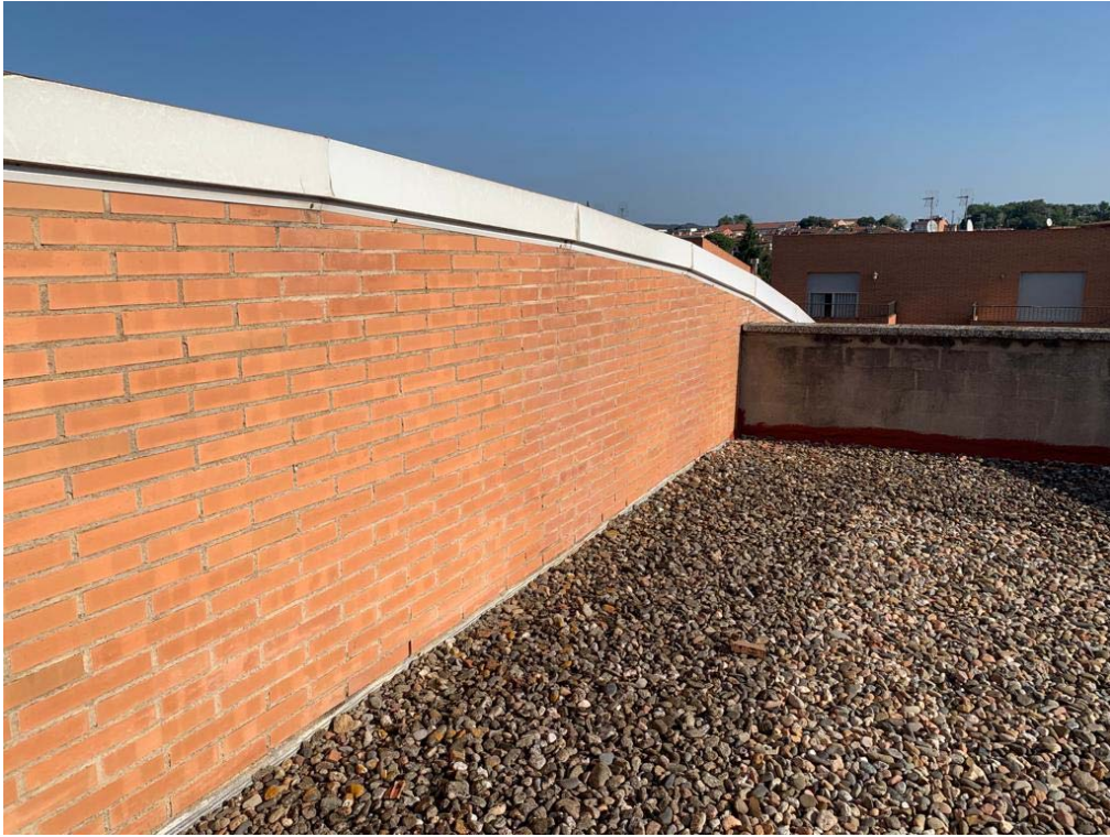
Detall trobada coberta plana amb parament vertical coberta zona B
