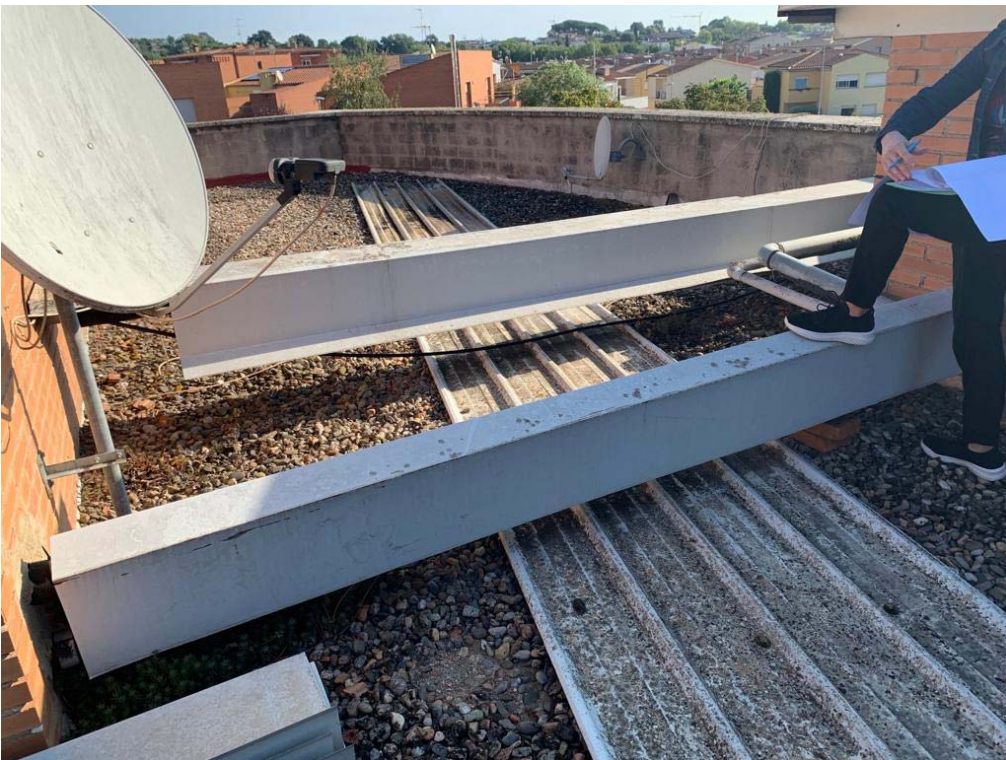
Fotografia de la coberta Zona B
