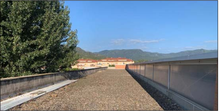
VISTA 4. COBERTA PLANA
