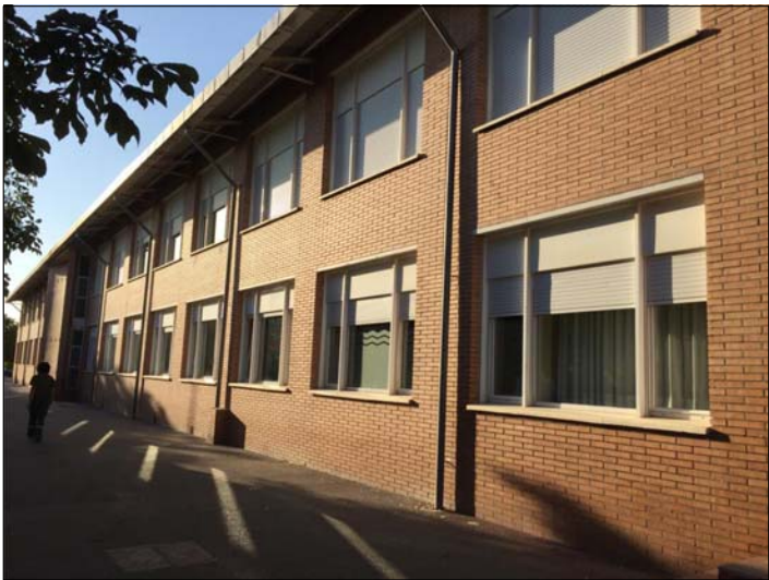
VISTA 1. FAÇANA CARRER SALVADOR ESPRIU
