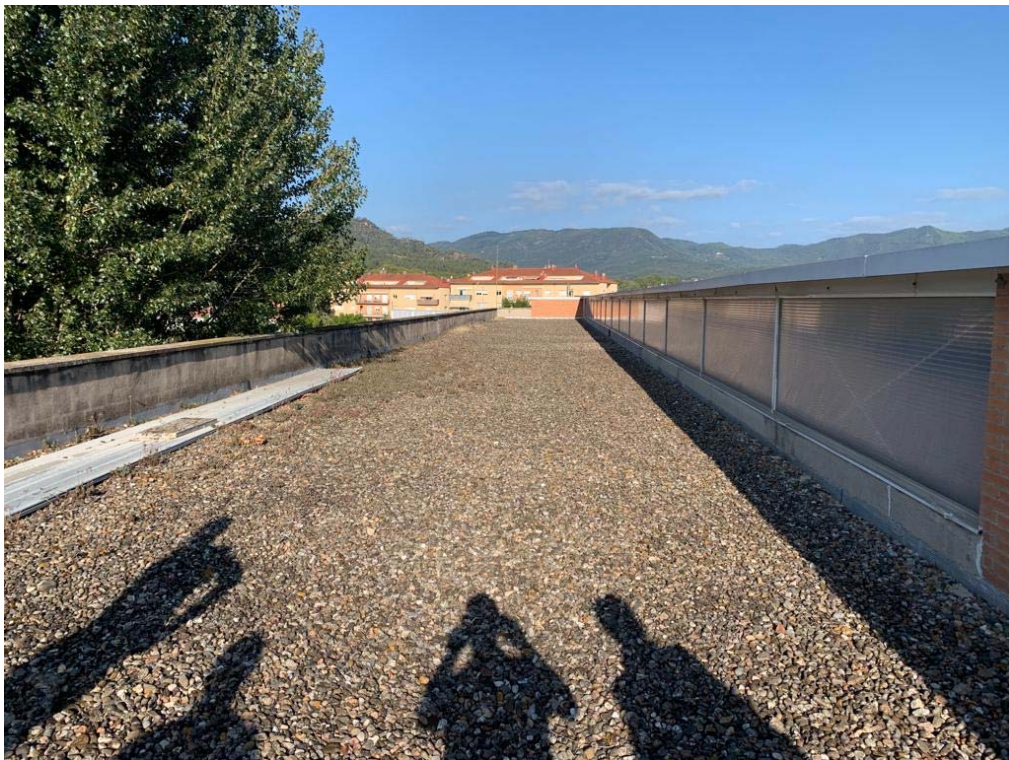
Fotografia de la coberta zona A
