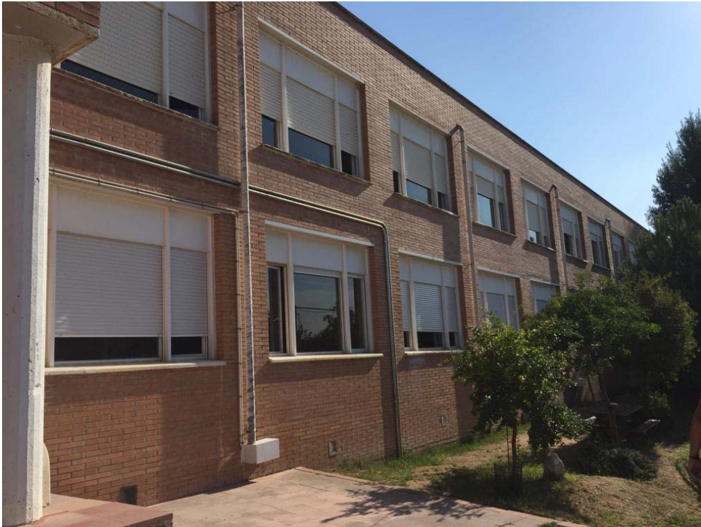
Façana al pati de les aules de l'edifici 1
