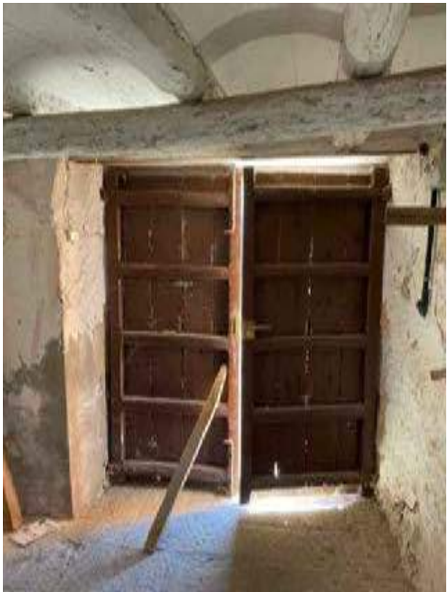
ACCÉS DES DE CARRER DEL SOL
