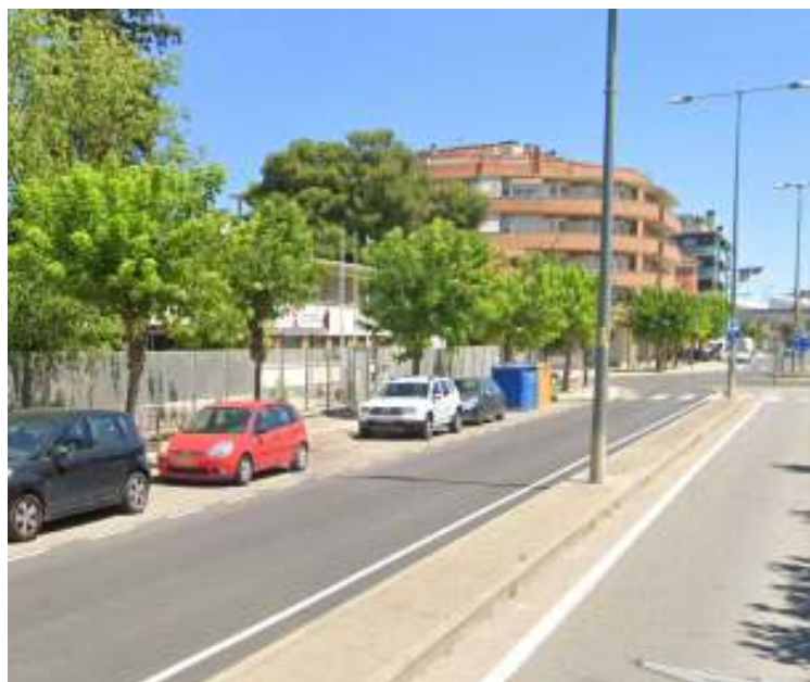
Foto 12 - Ampliació de vorera per eliminar zona d'aparcament
