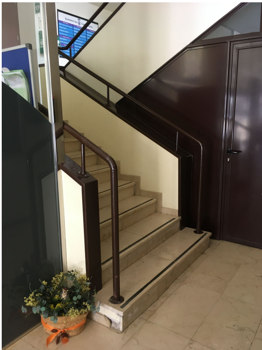
Recorregut Accés a l'Ascensor 02
