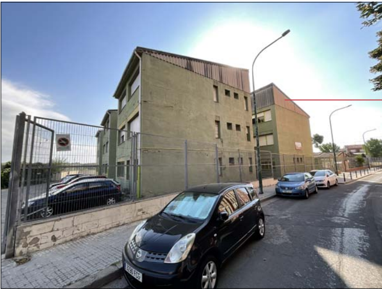
RETIRADA DE FALDÓ DE FIBROCIMENT DE FAÇANA
