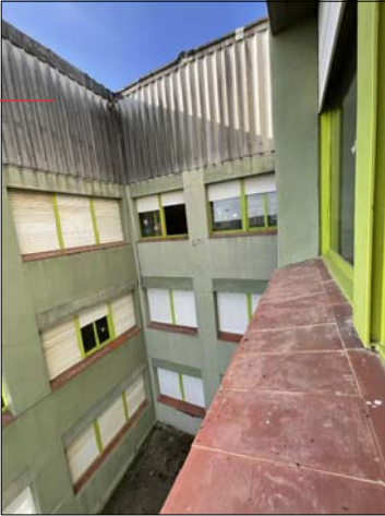
RETRADA DE FALDÓ DE FIBROCIMENT DE FAÇANA
