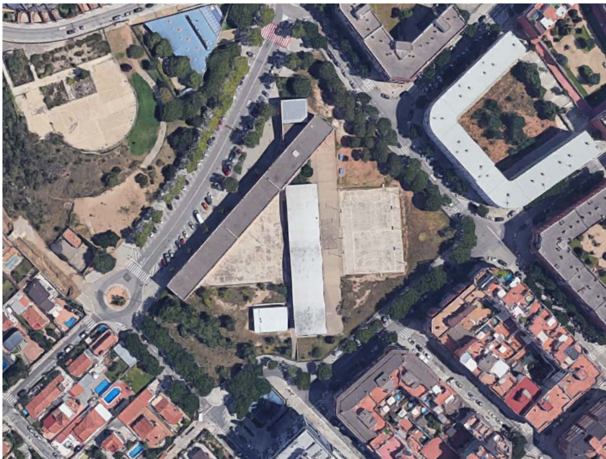
Img.1 – Vista aèria del centre escolar. L'edifici principal acull l'aulari
