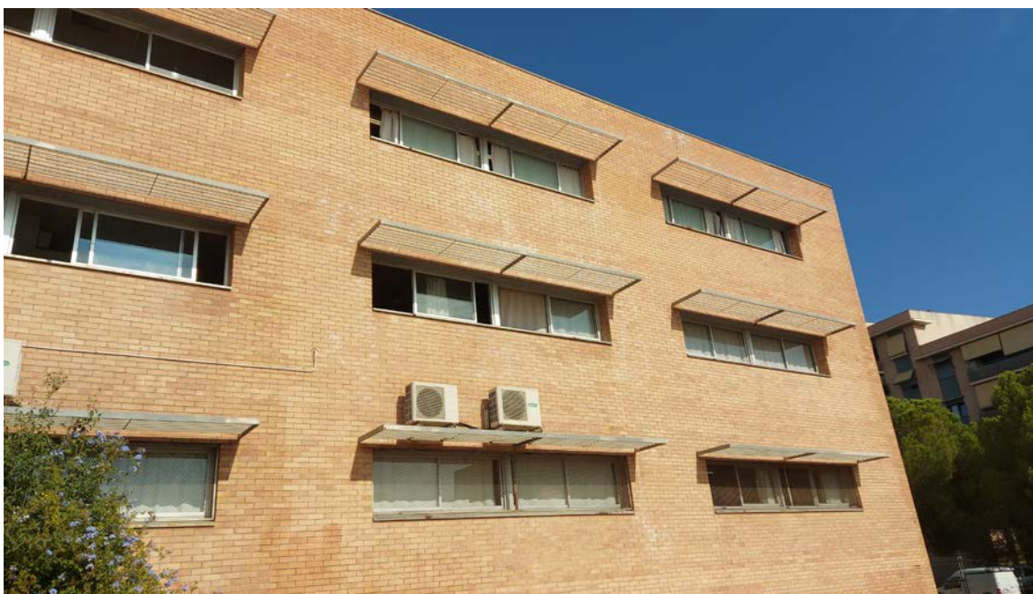
Fotografia de la façana sud a les 10.30 del 21/09 amb l'ombra aportada pel brise soleil a les finestres de les aules
