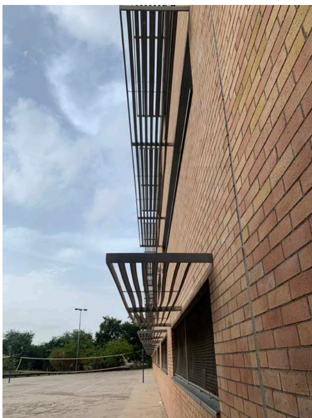
Img.4 i 5 – Detall façana: brise soleil i fusteria
