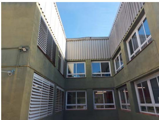
Img.3 i 4 – Tester i patis, amb els revestiments verticals en fibrociment
