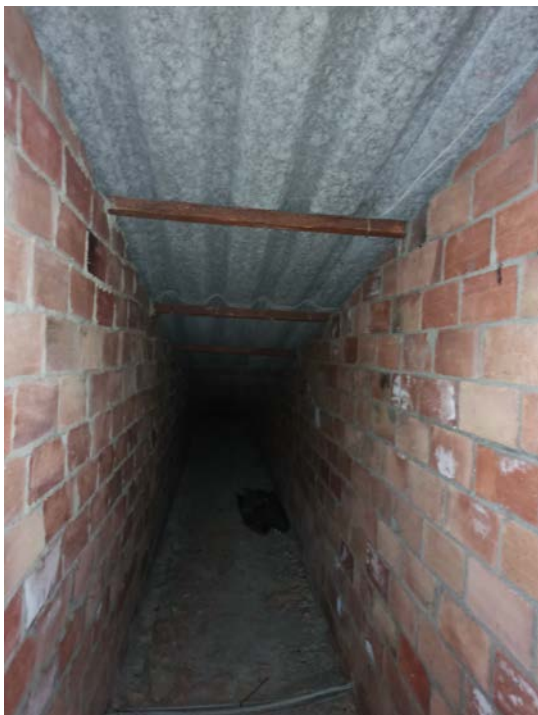
Img.7 i 8– Espais sota-coberta, amb envanets morts de recolzament de la coberta existent i corretges metàl·liques de suport
