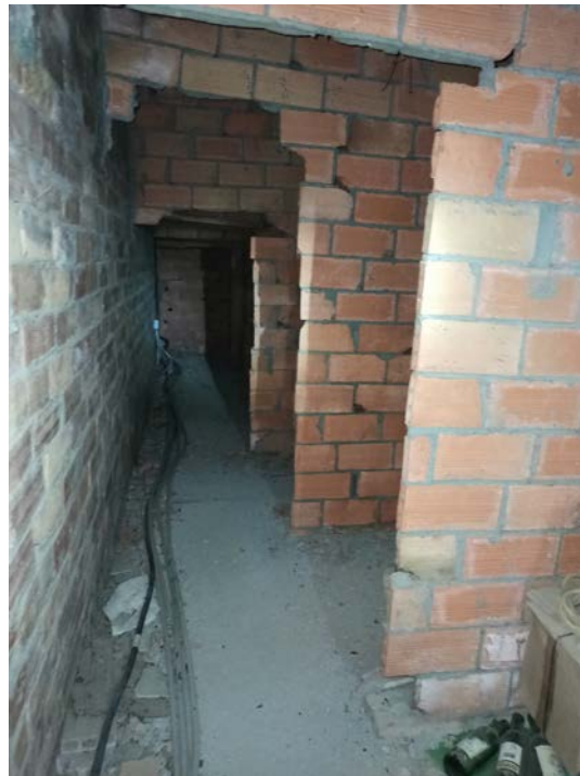
Img.7 i 8– Espais sota-coberta, amb envanets morts de recolzament de la coberta existent i corretges metàl·liques de suport
