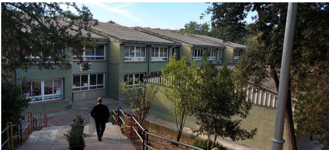
Img.2 – Vista exterior. La coberta ja disposa de canals de recollida d'aigua de xapa
