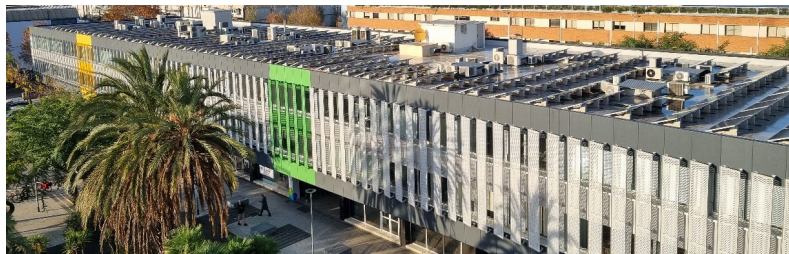
Coberta plana amb línia de vida amb ancoratges intermitjos
