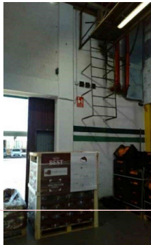
Escala d'accés a passarel·la interior
