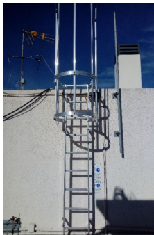
Detall escala accés a badalot de coberta
