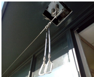
Detall ancoratge en voladís plantes 1 a 6
