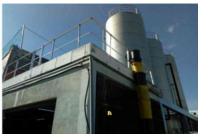
Coberta amb barana perimetral i porta d'accés
