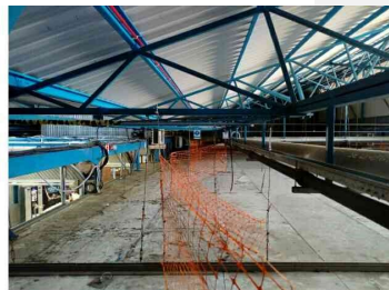
Detall de la zona de fals sostre
