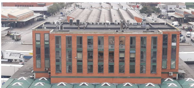
Coberta edifici oficines pavelló G
