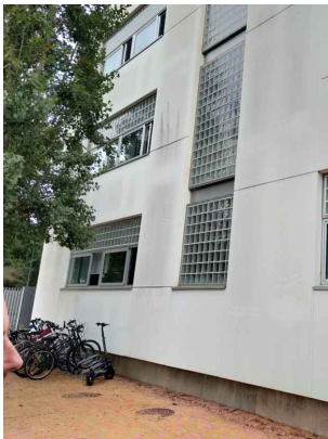
Fusteria de Planta 2 substituïda en la Fase 1.
