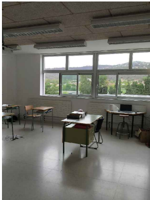
Fusteria de Planta 2 substituïda en la Fase 1.
