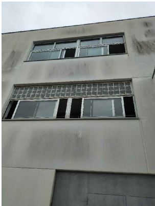
Fusteria de Planta 2 substituïda en la Fase 1.
