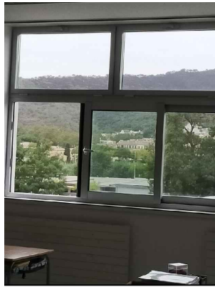
Fusteria de Planta 2 substituïda en la Fase 1.
