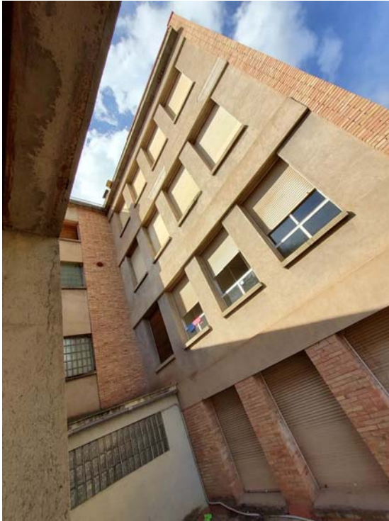
Pati entre volums. Façana sud.
