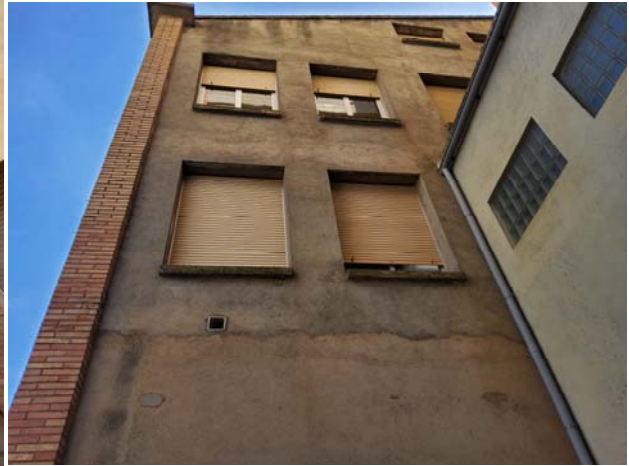
Pati entre volums. Façana nord
