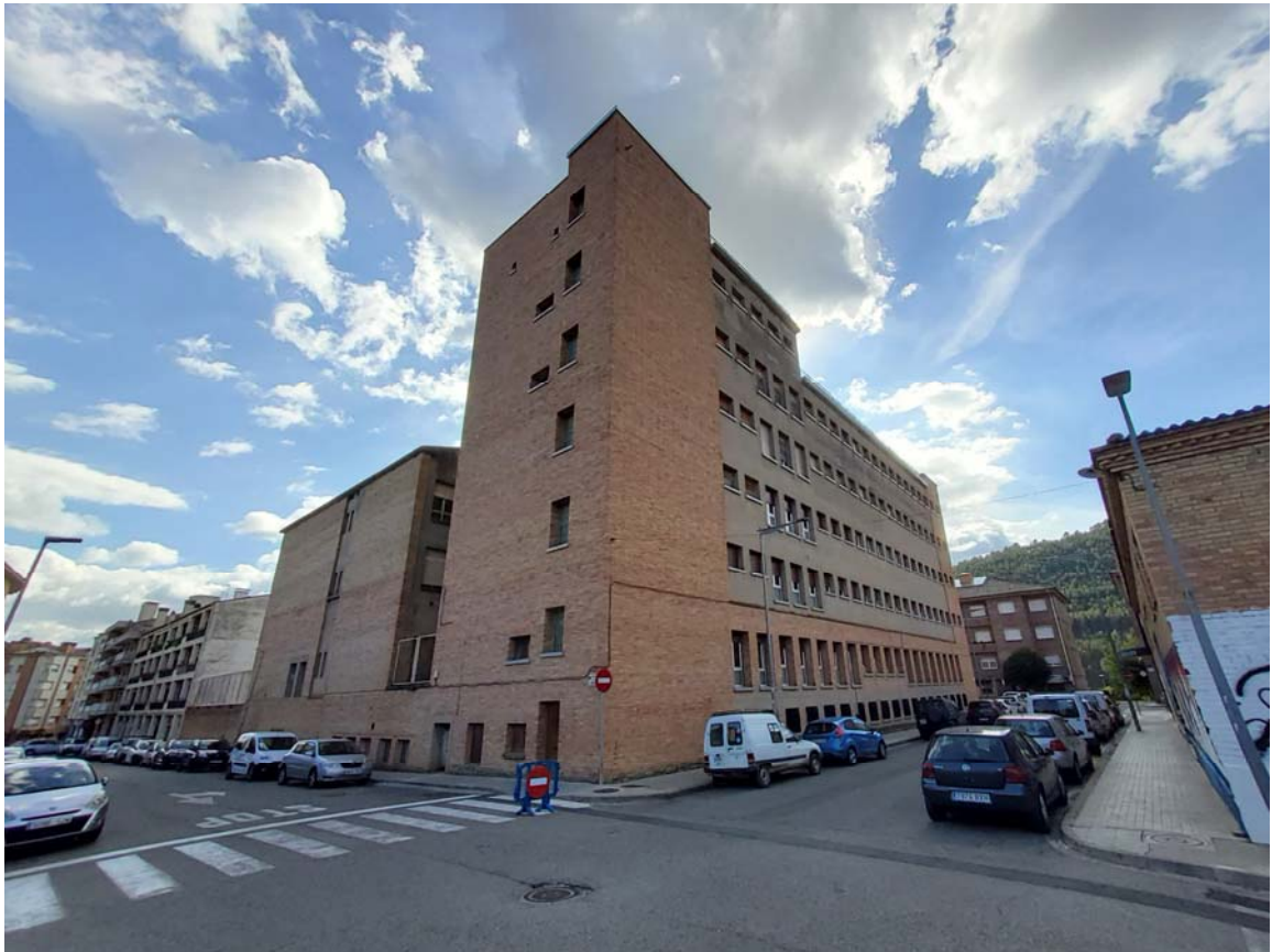
Cantonada nord-est. Avinguda Pirineus i Avinguda de Madrid.
