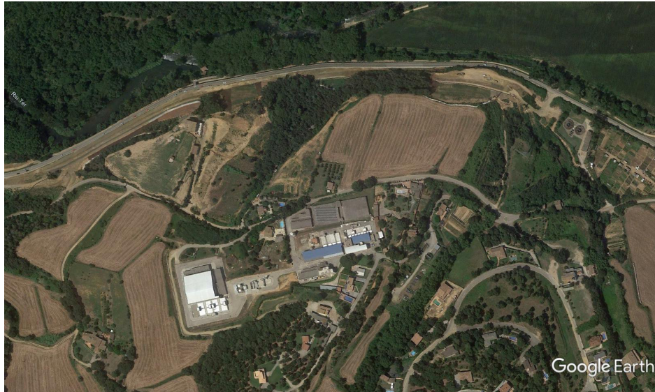
Figura 3. Vista aèria del recinte de l'ETAP de Montfullà, amb la planta que dona servei a l'Ajuntament de Girona a la dreta i la planta de nova construcció per al reforçament de l'abastament a la Costa Brava a l'esquerra, amb la coberta de color blanc i encerclada en color vermell.
