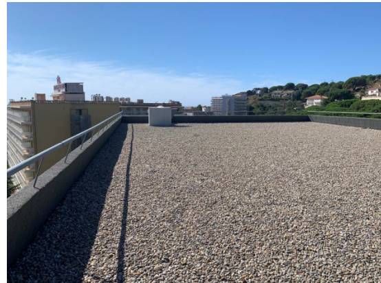
Coberta blocs carrer
