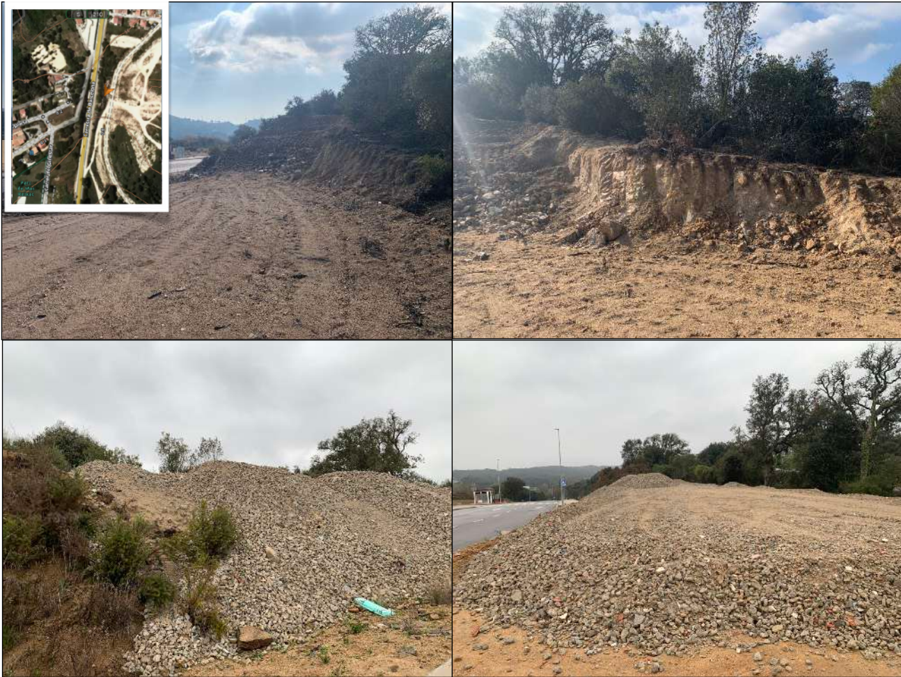
Figura núm. 19: Moviment de terres a la zona assenyalada a la imatge que se situa al costat del vial paral·lel a la carretera N-II i immediatament al damunt de la zona S3 d'actuació. A dalt, fotografies efectuades al gener de 2022. A baix, fotografies de març de 2022 on s'observa incorporació de residus de construcció. (Font: elaboració pròpia i programari SIG "Gaia GPS").
