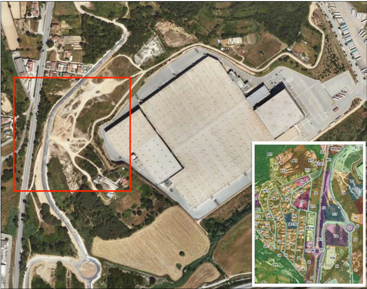
Figura núm.20: Localització Zona 2. (Font: elaboració pròpia).
