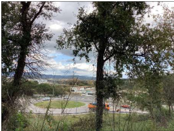
Figura núm.26: Visió de la nau industrial des del carrer Romaní (Font: elaboració pròpia)
