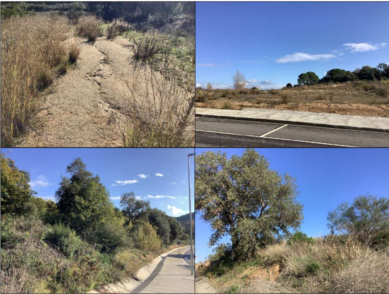
Figura núm. 21: Mostra de l'estat actual de la Zona 2 (Font: Elaboració pròpia).
