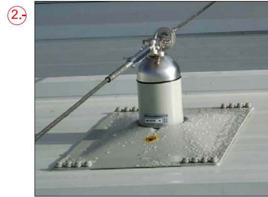
2.- Línea de vida sobre panel sandvitx tram recte
