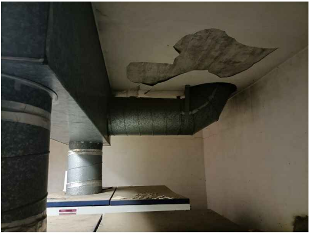
Foto 3: Sortida de fums interior a retirar
