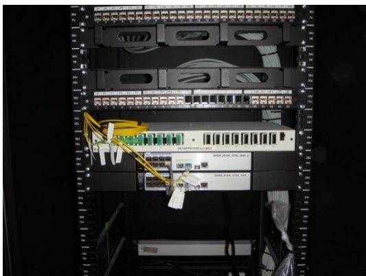
Exemples d'instal·lació de Repartidor de Fibra Òptica
