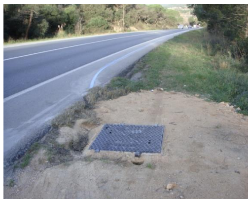
Exemple de l'estat de la canalització acabada
