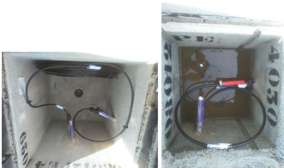
Exemples Terminació microductes en pericó
