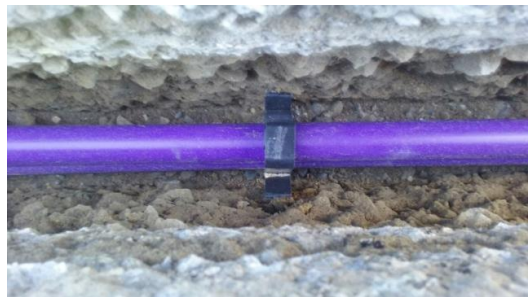
Centrador plàstic per homogeneïtzar la distribució del morter.
