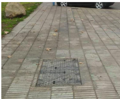
Exemple pericó tipus C2 en Vorera
