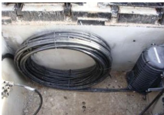
Detall interior pericons tipus C
