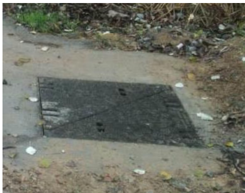
Exemple pericó tipus B2 en terres
