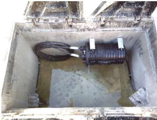
Exemples d'instal·lació de Caixes d'Empiulament dins de Pericó
