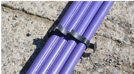
Centrador plàstic per homogeneïtzar la distribució del morter.
