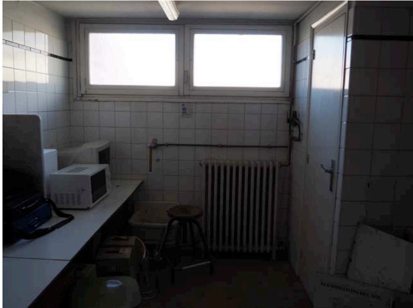
Interior de la sortida a la coberta
