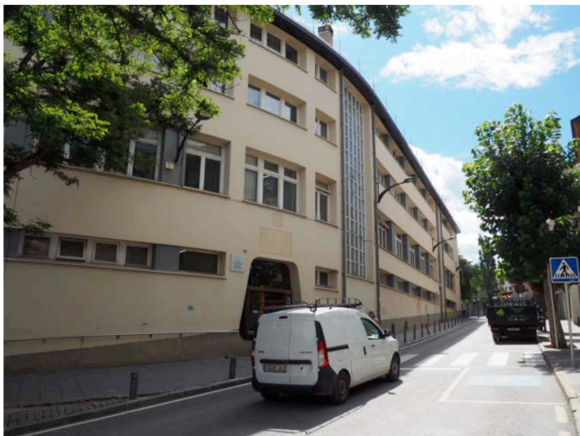
Façana carrer Escoles Pies
