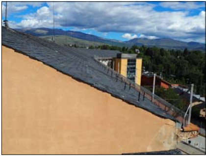
VISTA DES DE L'EXTREM SUD DE LA COBERTA
