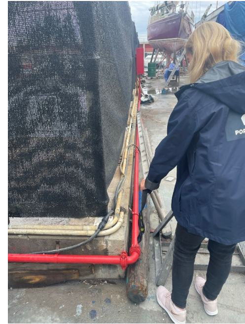
Figura 6. Pas instal·lacions aigua, contra incendis i BT
