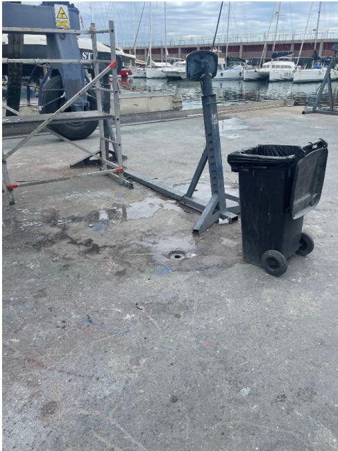
Figura 10. Zona ubicació separador d'hidrocarburs projectat
