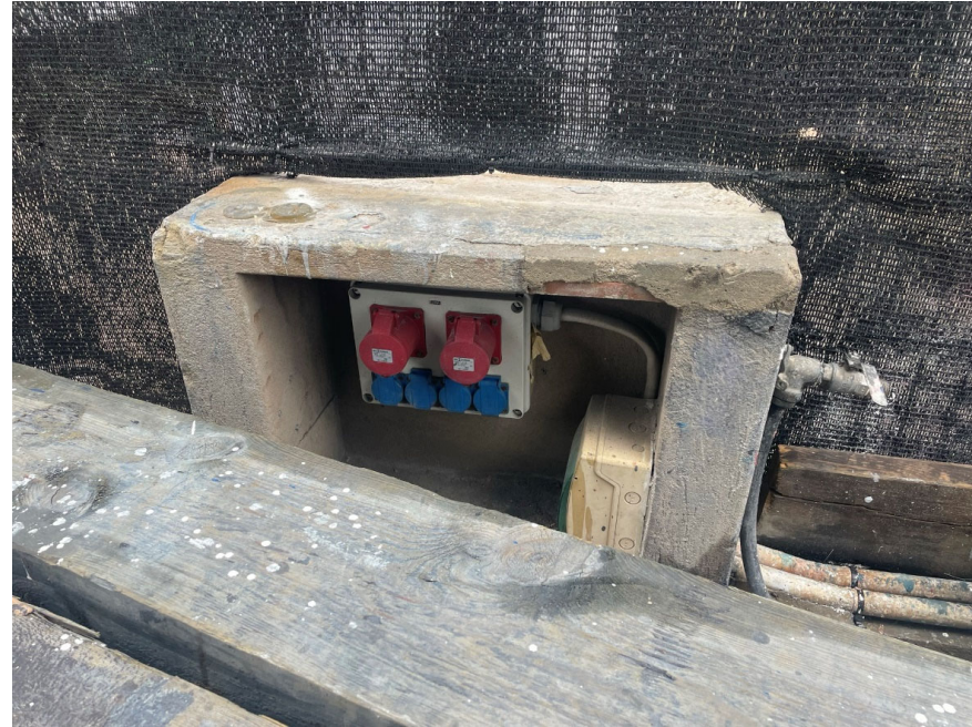
Figura 7. Punt d'alimentació elèctrica existent
