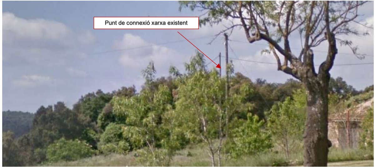
Punt de connexió (pal de fusta)
