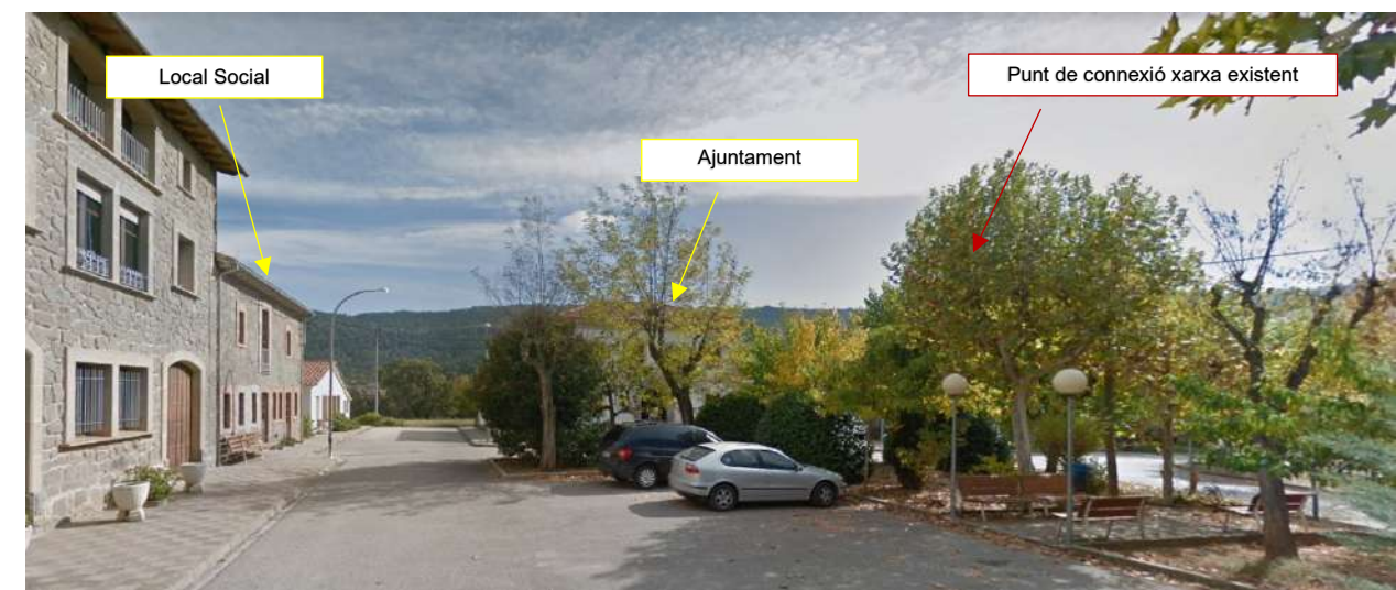
Ajuntament, local social i punt de connexió existent (pal de fusta)
