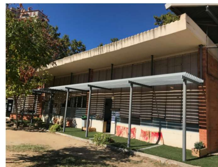
FAÇANA SUD, EDIFICI C
