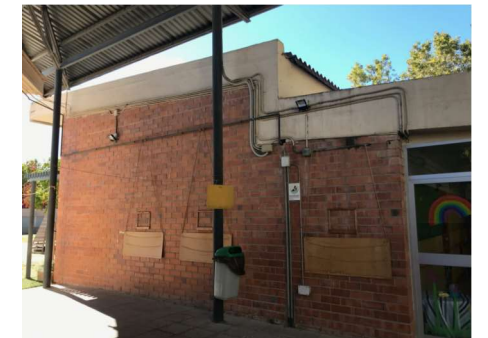
FAÇANA EST, EDIFICI C.
