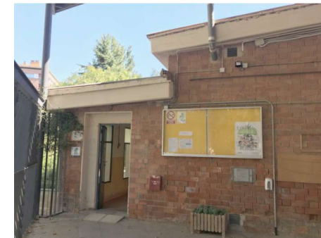
FAÇANA OEST, EDIFICI B.
