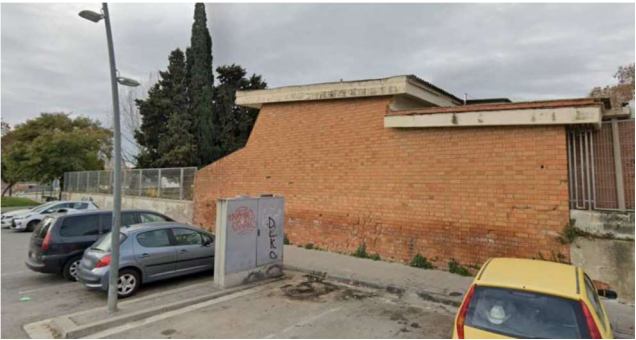
FAÇANA EST, EDIFICI A.
