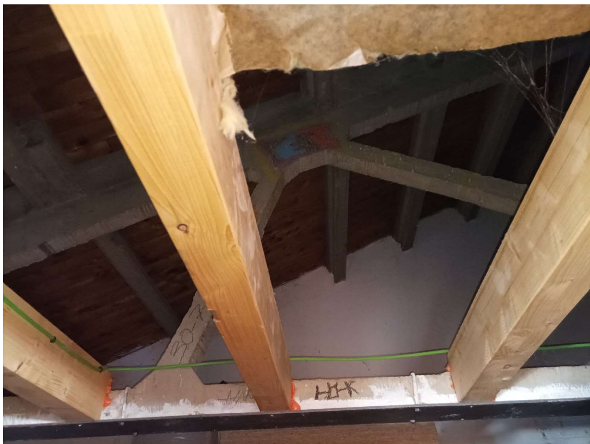
Interior sota-coberta edifici gimnàs
