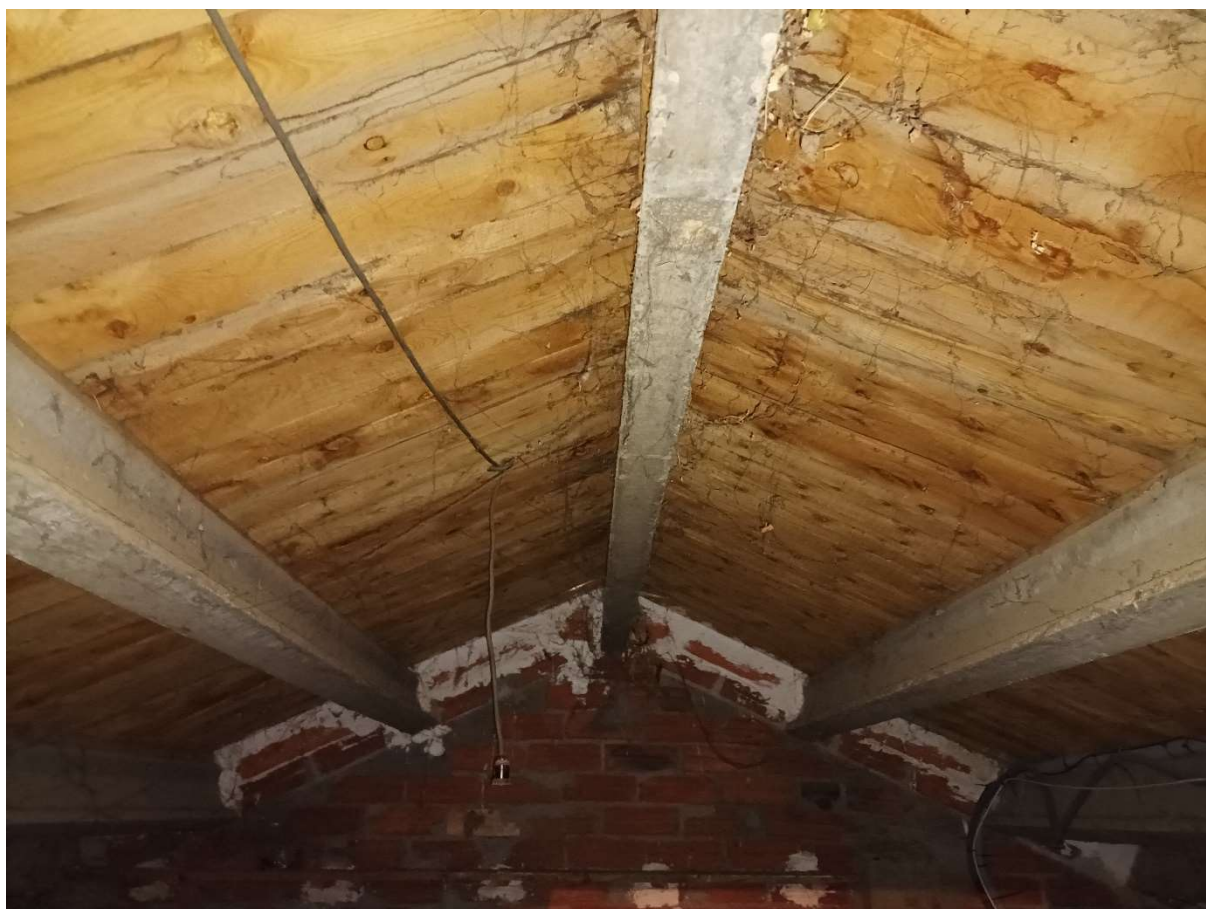
Interior sota-coberta edifici annexa al gimnàs
