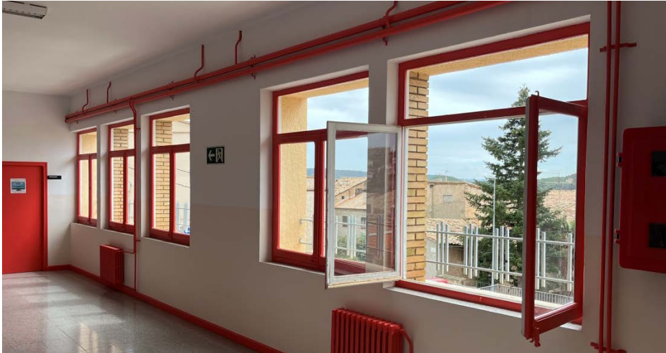
Fusteries de fusta amb vidre simple i sense persiana
