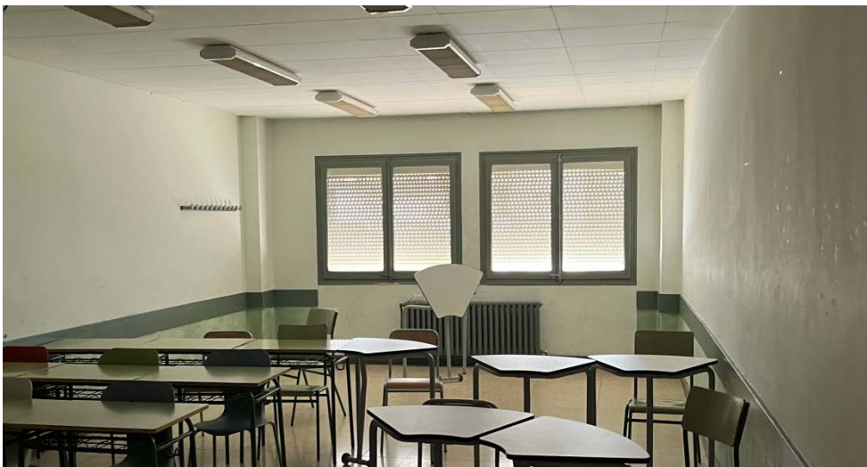
Fusteries de fusta amb vidre simple amb persiana
