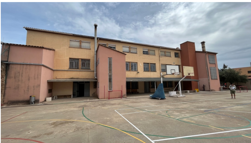
Cara Oest – Façana i pista esportiva
