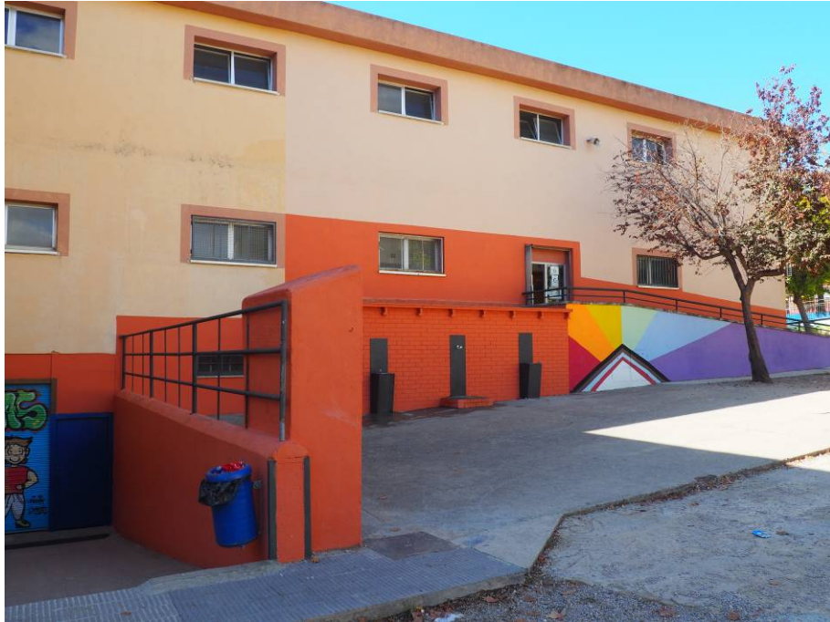
Façana Nord-Est Edifici 2
