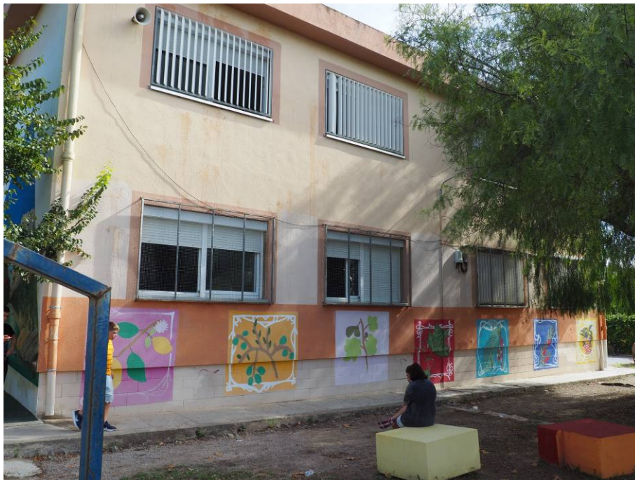
Façana Sud-Oest Edifici 2.
