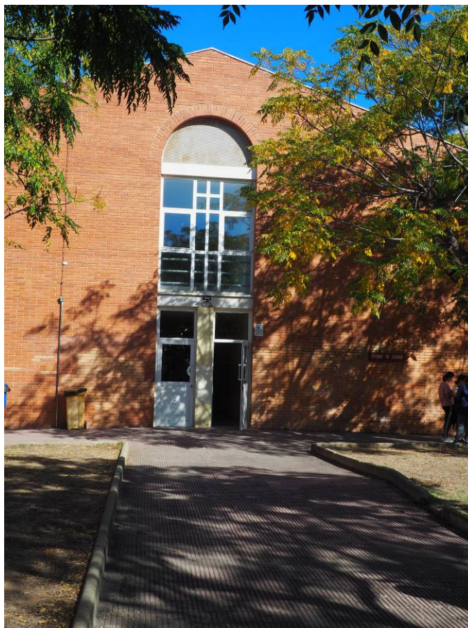
Façana Sud Edifici 1. Ala interior.
