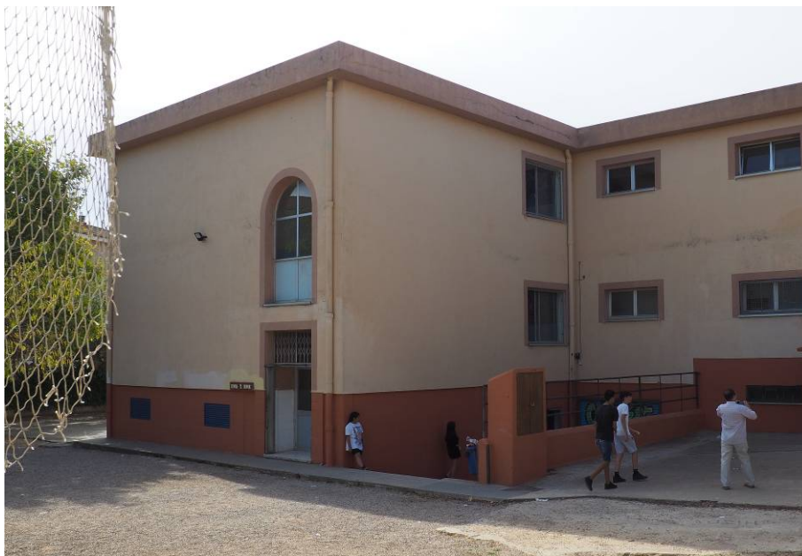
Façana Nord-Est Edifici 2
