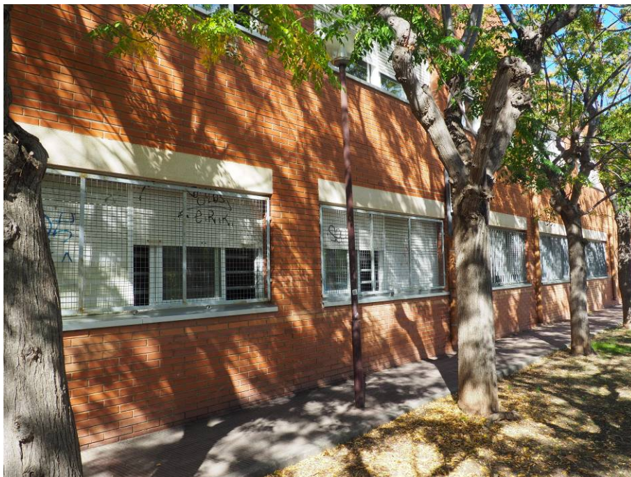
Façana Est Edifici 1. Ala interior.
