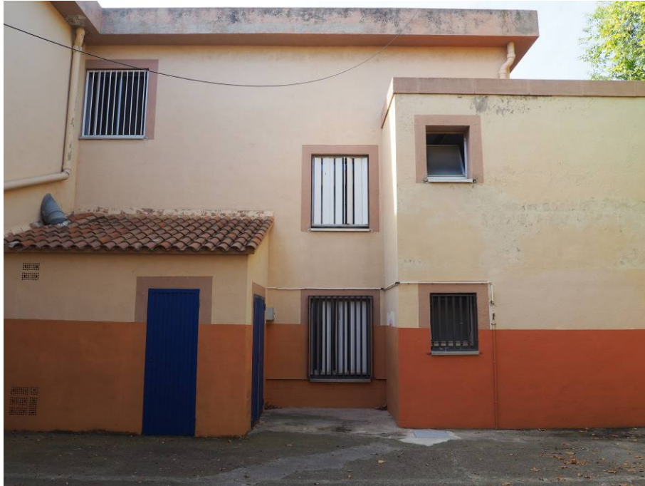
Façana Nord-Est Edifici 2
