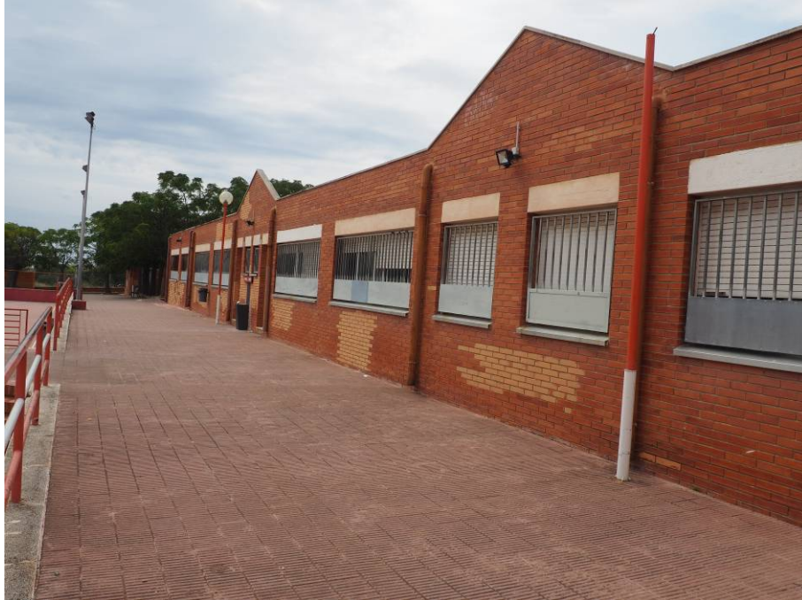
Façana Est Edifici 1. Ala del carrer Jaume Pellarès.
