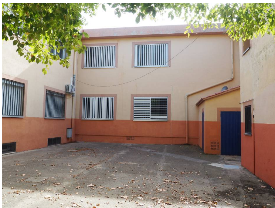
Façana Nord-Oest Edifici 2
