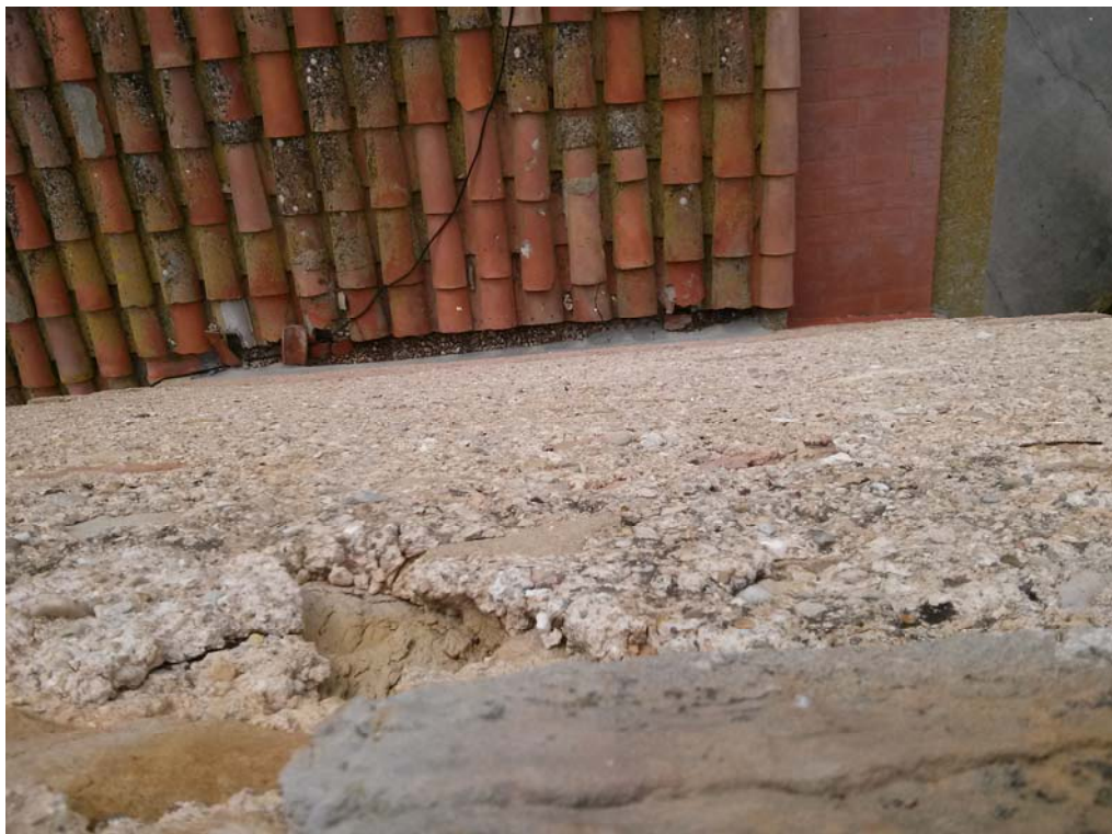
Vista de la coberta i de la canal interior des del campanar
