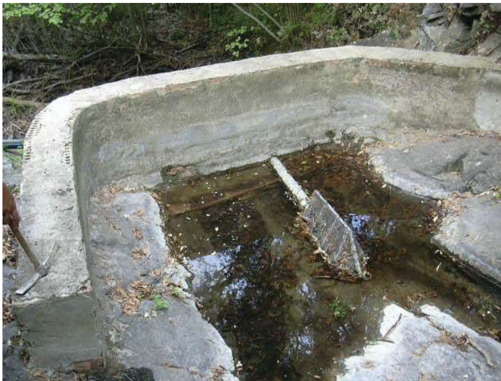
Fotografia 2. Presa del riu i filtre
