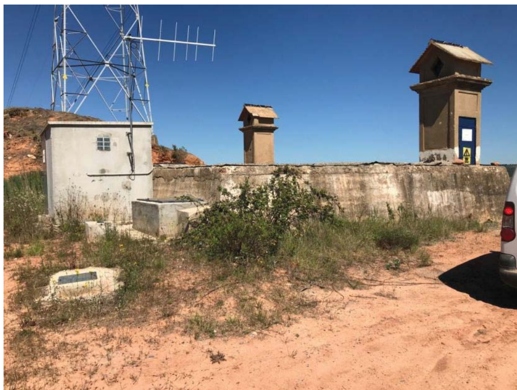
Fotografia 7. Vista exterior dipòsit Piponeta
