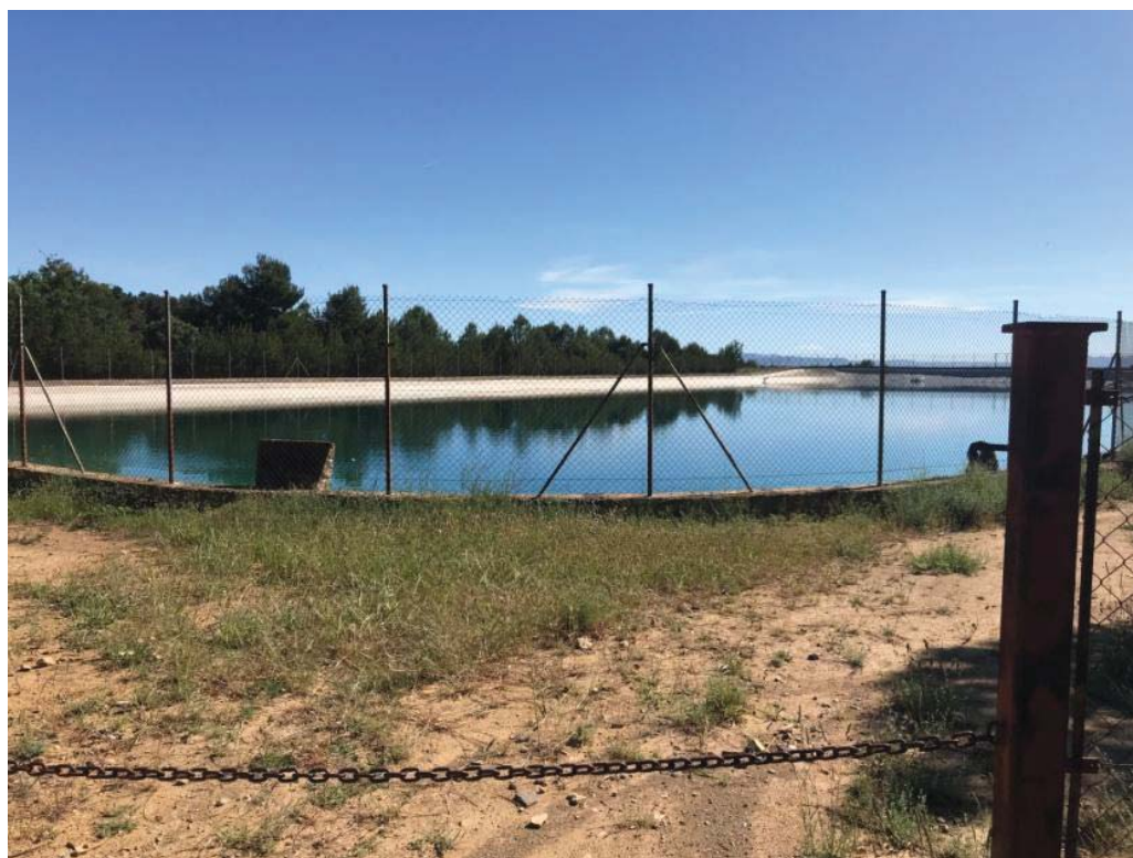
Fotografia 6. Vista general Bassa acumulació
