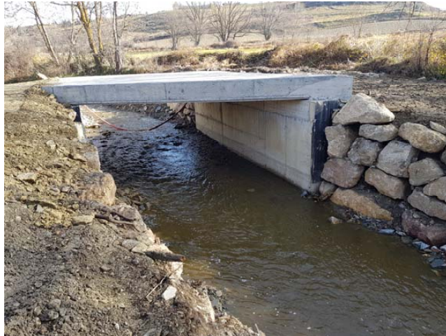
Obra executada en el pas nº 1 (executat el 2018)
