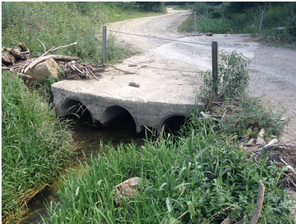
Primer pas (el situat més al nord) de 9,80 ml de longitud (pont nº 1, ara ja executat)
