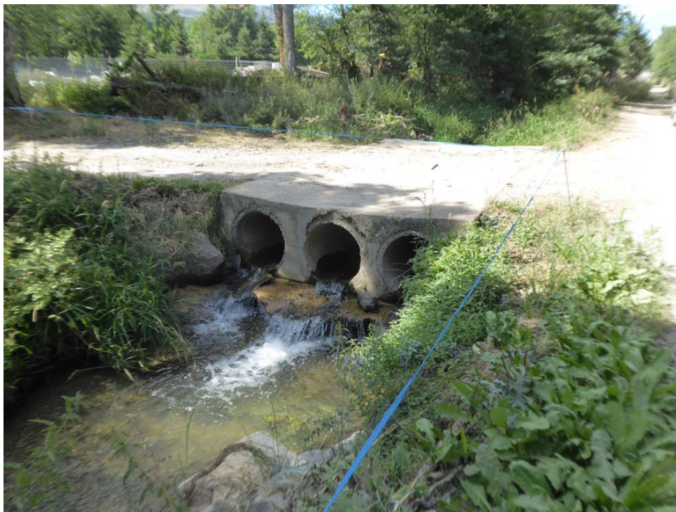
Tercer pas, de 6,50 ml de longitud i 3,50 d'amplada, tubs de DN 80 cm (pont núm. 3)
