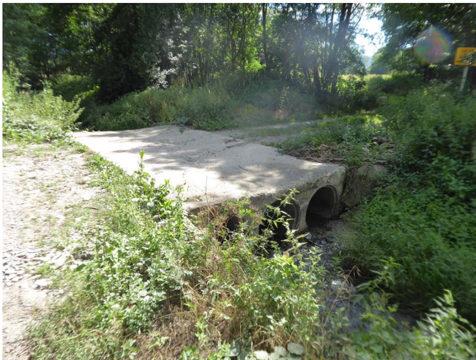
Quart pas, de 6,50 ml de longitud i 3,40 d'amplada, tubs de DN 80 cm (pont nº 4)
