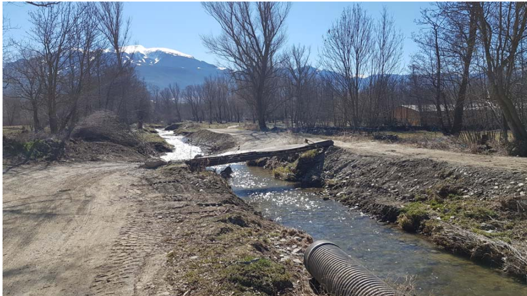
Cinquè pas, gual format amb plaques prefabricades de formigó (pont nº 5)
