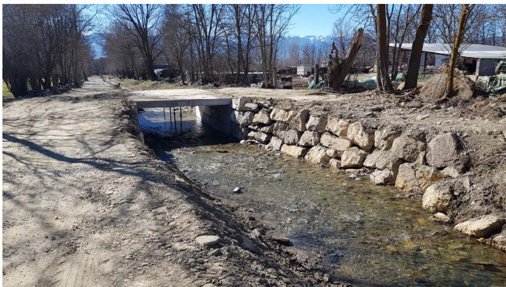
pont nº 2, ara ja executat, amb plaques pretensades
