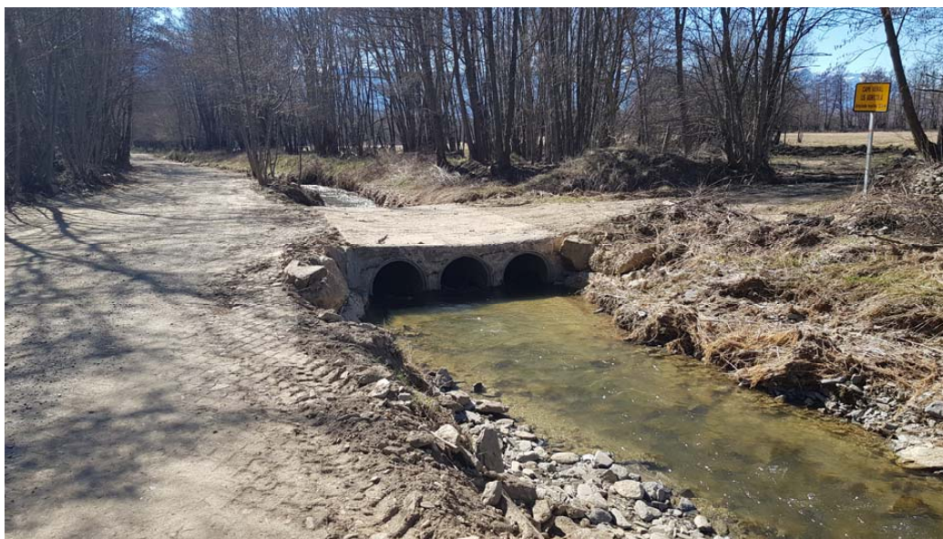
Quart pas, de 6,50 ml de longitud i 3,40 d'amplada, tubs de DN 80 cm (pont nº 4)
