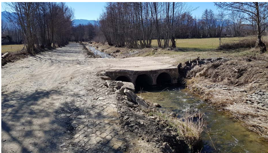
Tercer pas, de 6,50 ml de longitud i 3,50 d'amplada, tubs de DN 80 cm (pont núm. 3)
