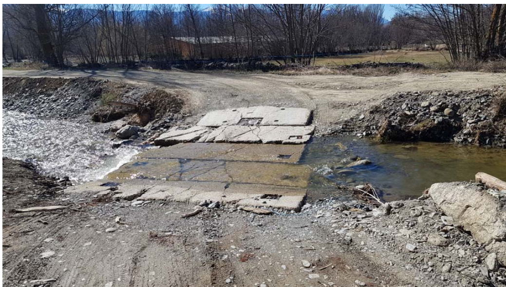
Cinquè pas, gual format amb plaques prefabricades de formigó (pont nº 5)
