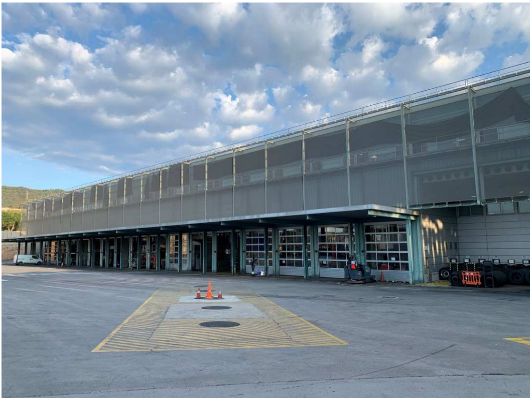
Edificio oficinas. Fachada sur
