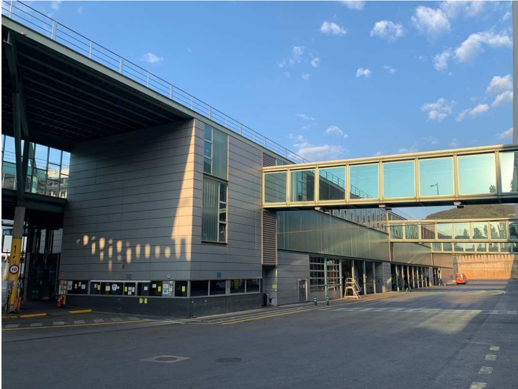
Edificio oficinas. Fachada norte
