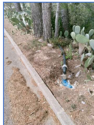
Imatge 6. PE DN63 sobre vorera al carrer Zamora
