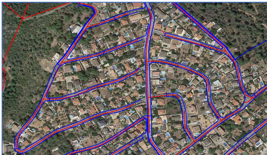
La configuració d'aquest sector igualment és com el sector de dalt. Es tracta de carrers estrets on les infraestructures soterrades, són les canalitzacions d'abastament d'aigua, una a cada costat del carrer, i la canalització de sanejament per les aigües residuals.
