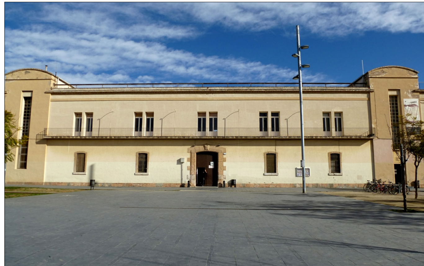
FAÇANA PLAÇA DE LES CASERNES
