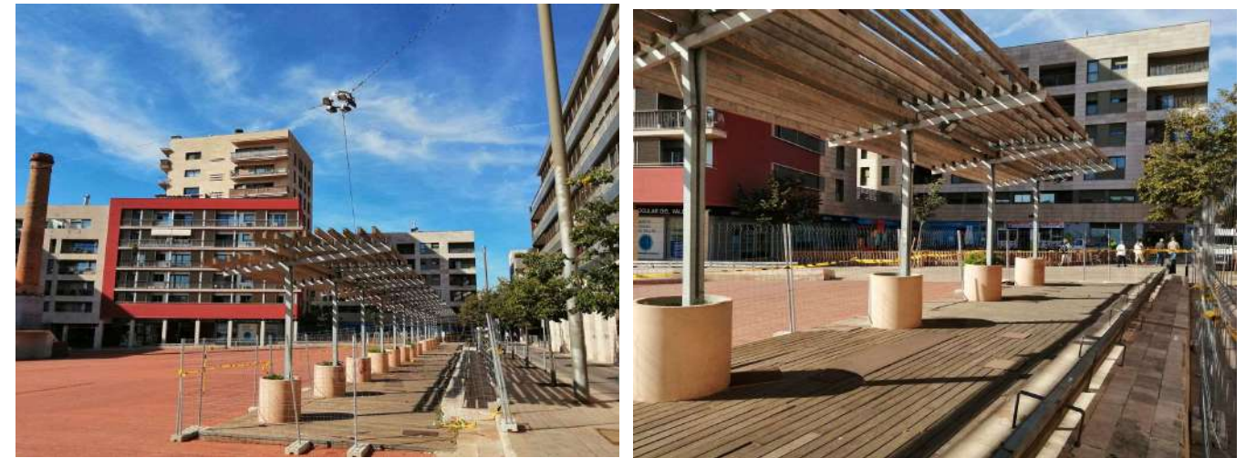
Vista de l'estat actual de la zona de la tarima
