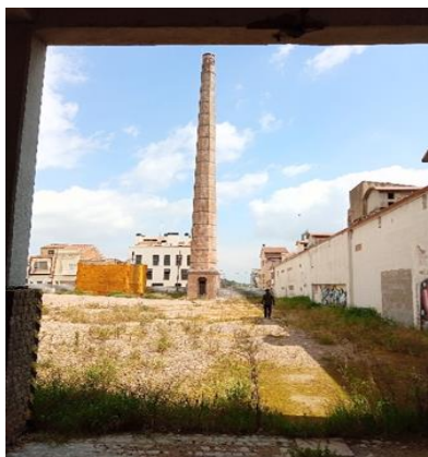
Imatges façana nord
