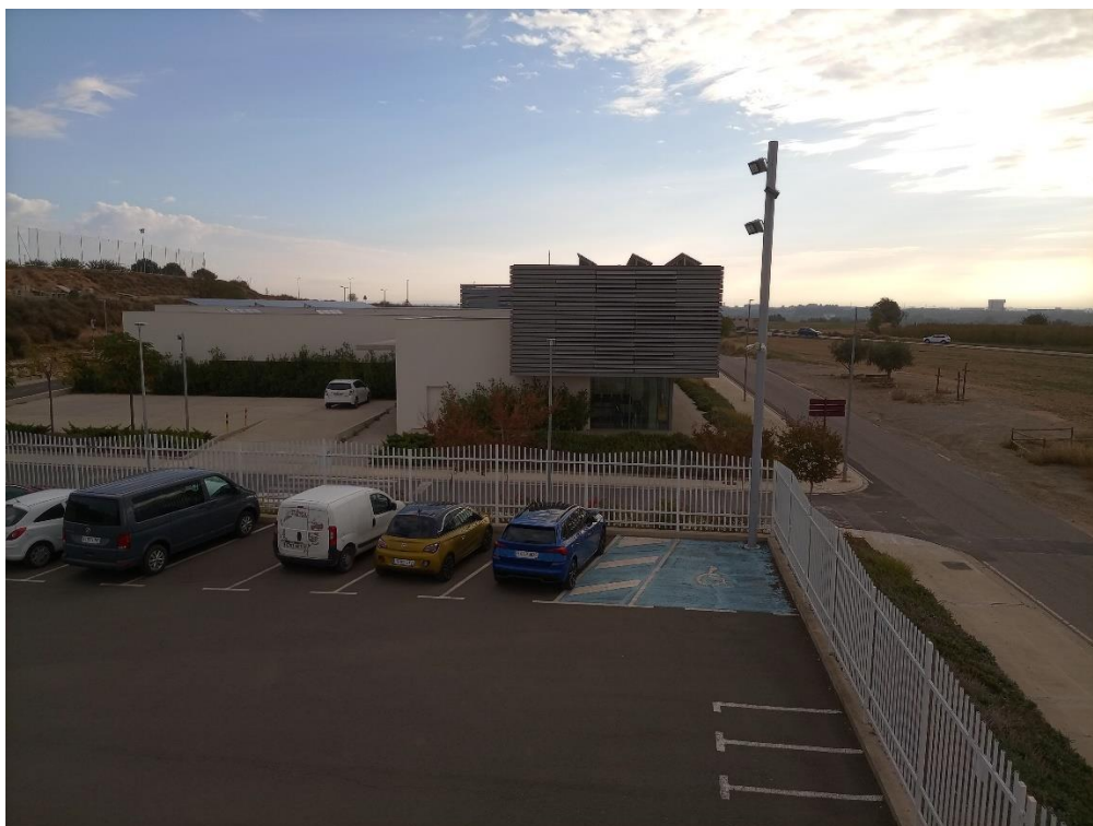
Fig. 12 Pàrquing objecte de la instal·lació de la marquesina solar
