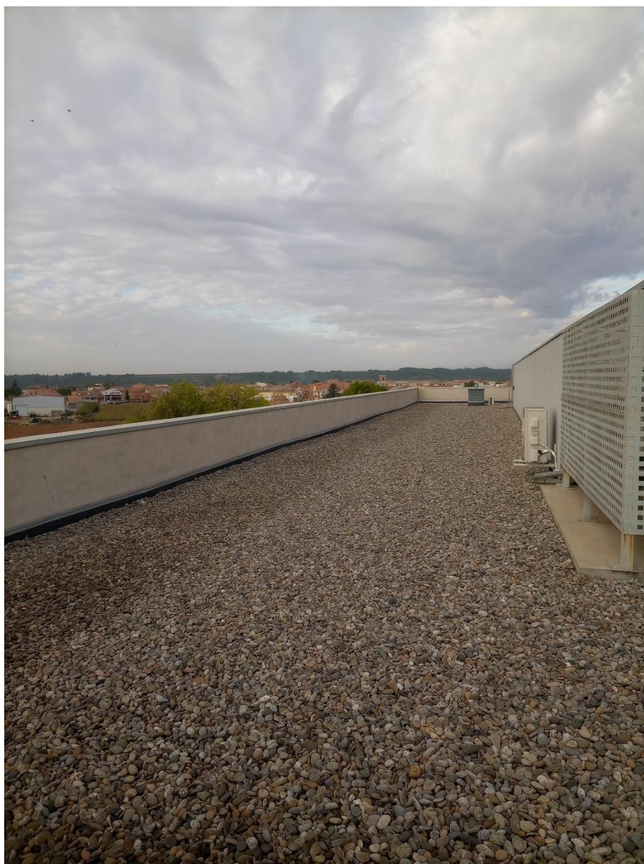
Fig. 10 Vista de la part sud de la coberta
