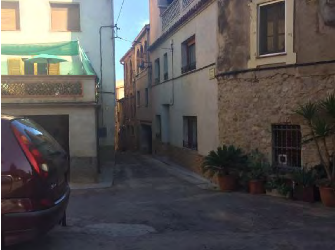
Vista del carrer Marià Llanvera, mirant cap a nord, on es pot veure els cables elèctrics a les façanes dels edificis
